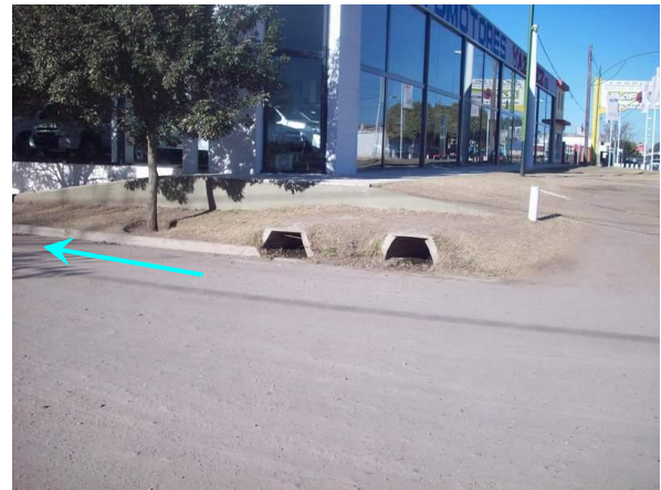
Figura 6-5 – Cruce del FFCC de la Subcuenca suroeste y como se distribuye sobre calle
