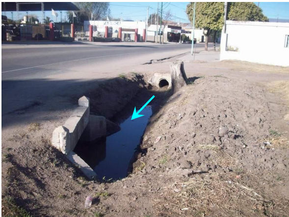
Figura 6-5 – Cruce del FFCC de la Subcuenca suroeste y como se distribuye sobre calle
