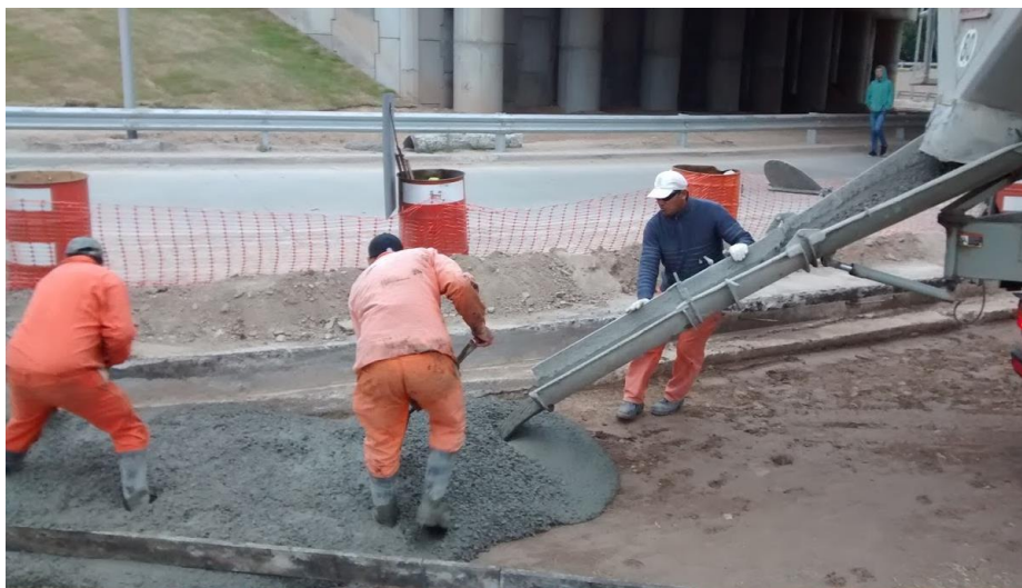
5.43 Colado del Hormigón H-8
