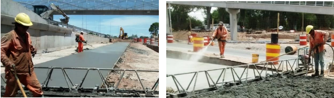
5.65 Rociado de la superficie de Hormigón con Antisol Sika
