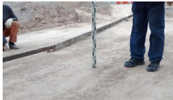
5.39 Control del nivel de las Reglas
