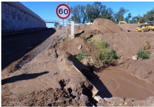
5.35 Banquina Derecha luego de los efectos de la escorrentía superficial
