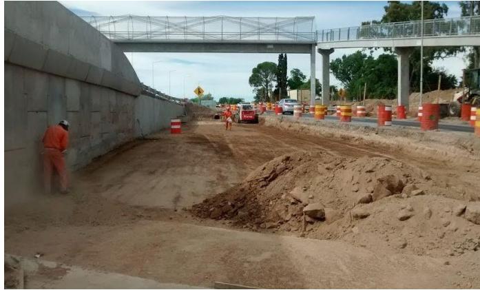
5.17 Tramo superior de la rama (de progresiva +300 en adelante)
