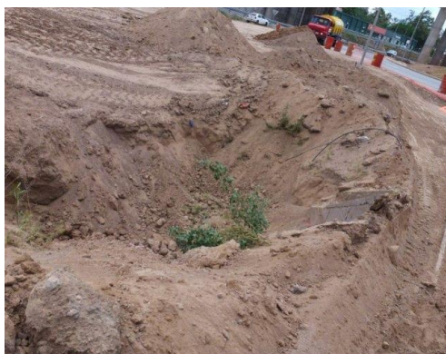
5.33 Cuenco disipador formado en el ingreso a la Alcantarilla
