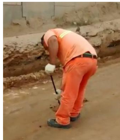
5.4 tanteo de la cancha en busca de baches y/o solapes
