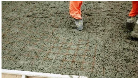
5.62 Colocación de la malla metálica de 4,5mm
