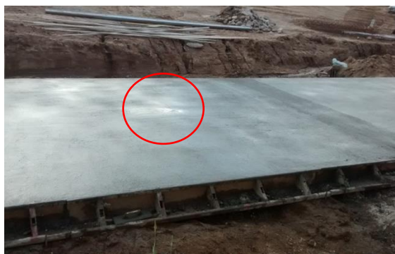
5.64 Losas de Hormigón H-35 terminadas
