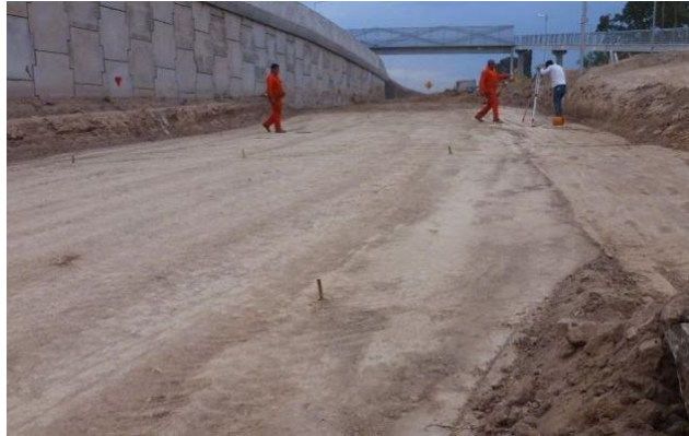
5.12 Nivelado de las estacas para el conformado de la subbase
