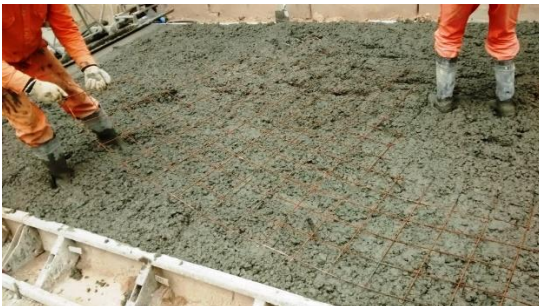
5.62 Colocación de la malla metálica de 4,5mm
