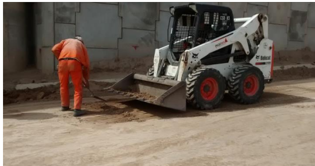
5.37 escarificado de una capa superficial que presentaba solapamiento
