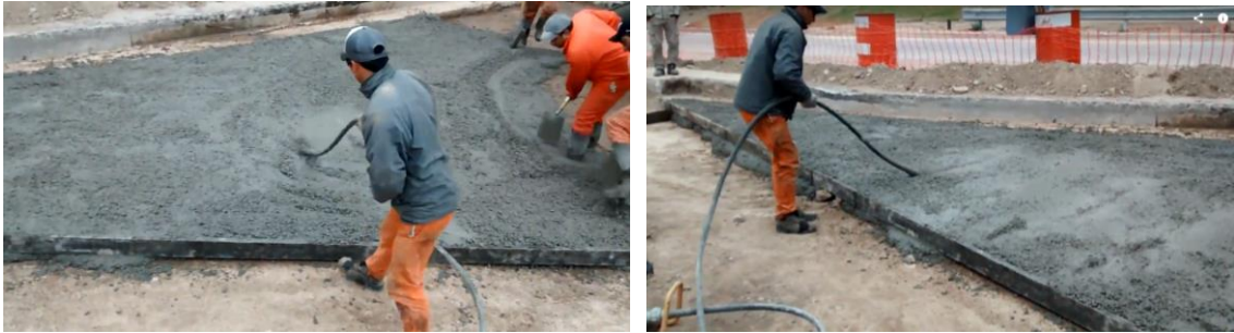
5.44 Vibrado del Hormigón H-8 con vibrador de tipo aguja
