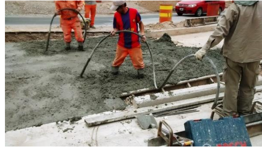
5.60 Colado y vibrado del Hormigón H-35
