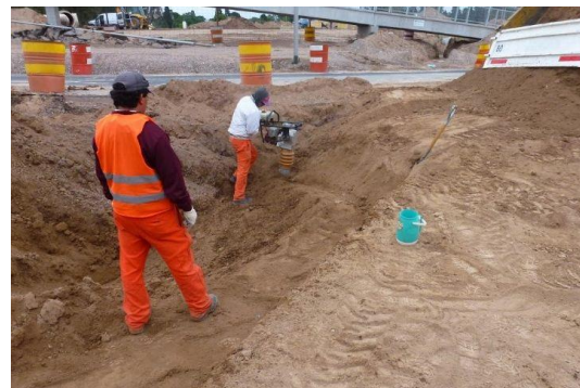
5.16 Volcado, distribución y Compactación de la mezcla suelo-cemento
