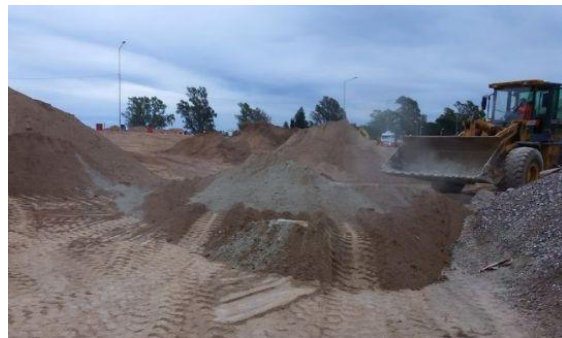
5.15 mezclado de bolsas de cemento y suelo en pie de obra
