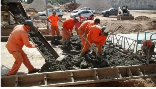
5.60 Colado y vibrado del Hormigón H-35
