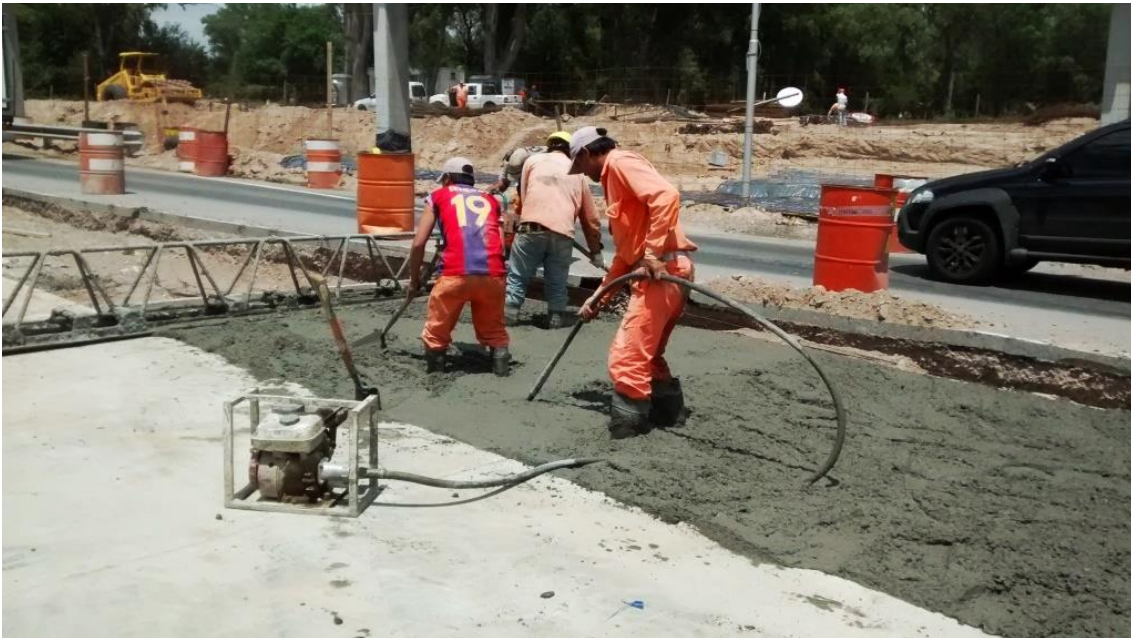
5.61 Distribución del H-35 con palas y vibrado con vibradores de punta
