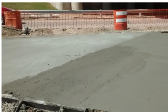
5.64 Losas de Hormigón H-35 terminadas
