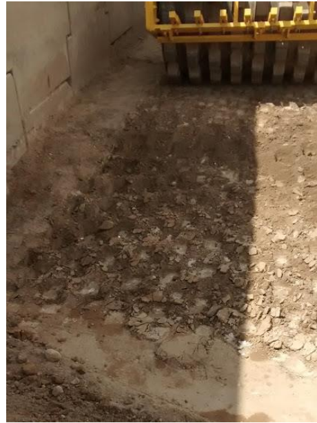
5.20 Exceso de humedad en la Subrasante contra muro de contención
