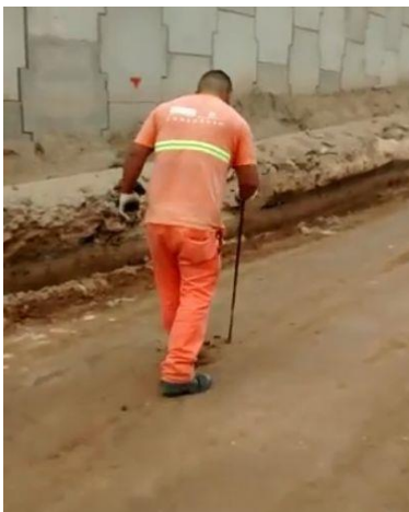
5.4 tanteo de la cancha en busca de baches y/o solapes
