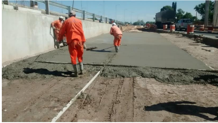
5.51 vista de la conformación de la base de Hormigón H-8 en el tramo superior
