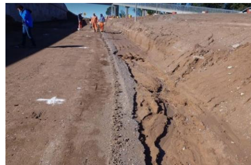
5.35 Banquina Derecha luego de los efectos de la escorrentía superficial
