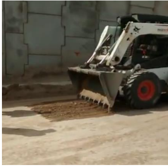
5.37 escarificado de una capa superficial que presentaba solapamiento
