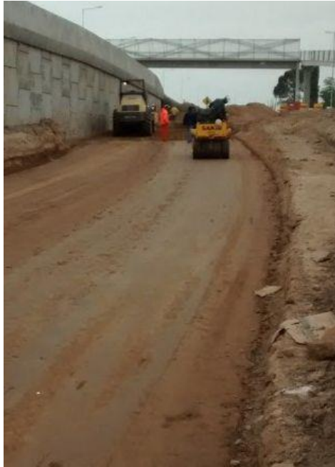
5.5 Compactado de la Subrasante
