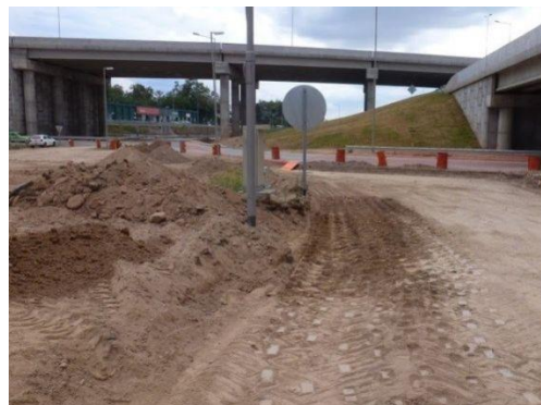
5.32 Banquina Derecha a sellar para conducir el agua hacia la alcantarilla
