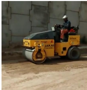
5.38 compactación del sector escarificado
