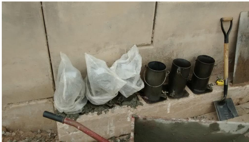
5.59 Probetas cubiertas con bolsas para mantener la humedad
