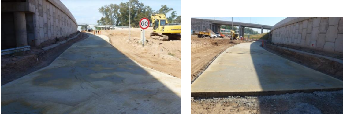
5.48 Capa de base hormigón H-8 terminada
