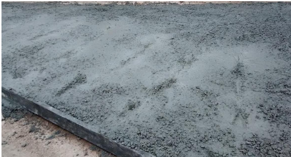
5.45 Hormigón H-8 luego del Vibrado
