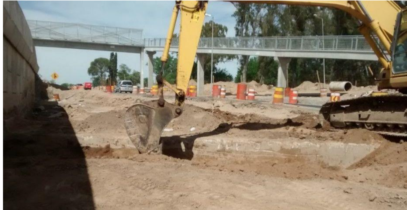
5.14 Retroexcavadora removiendo el suelo de la zona
