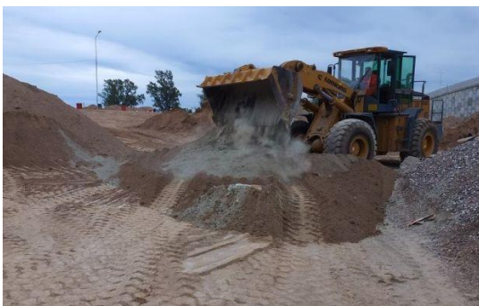
5.15 mezclado de bolsas de cemento y suelo en pie de obra
