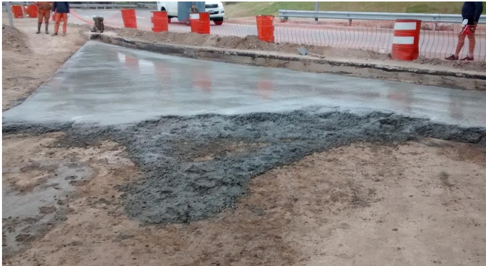
5.47 Antisol Sika aplicado a la superficie
