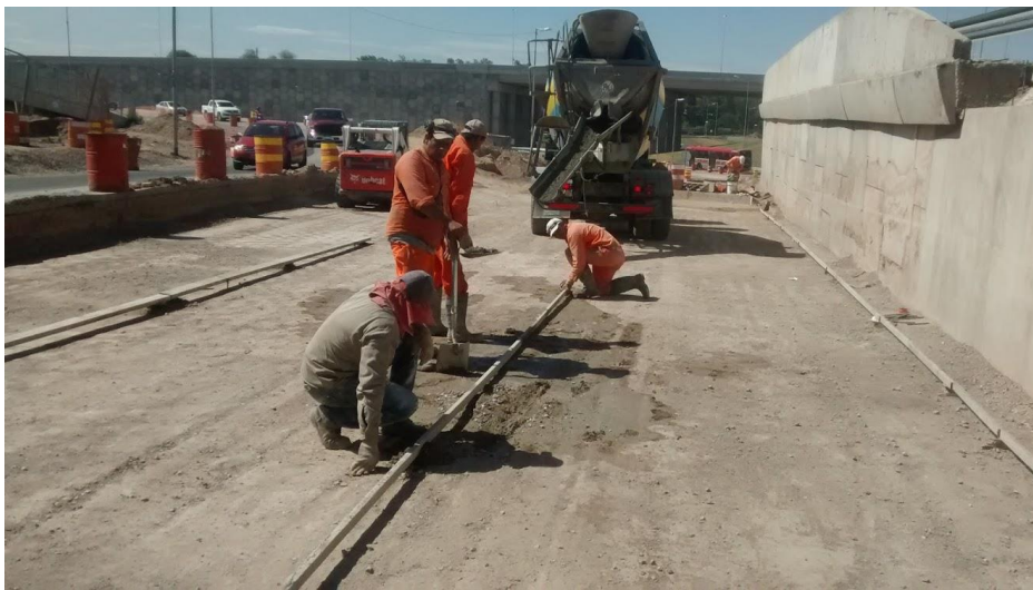
5.49 Operarios realizando el encofrado para la base en el tramo superior
