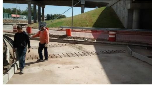
5.53 Presentación de las mallas metálicas, cama pasadores y barras de unión previo al colado
