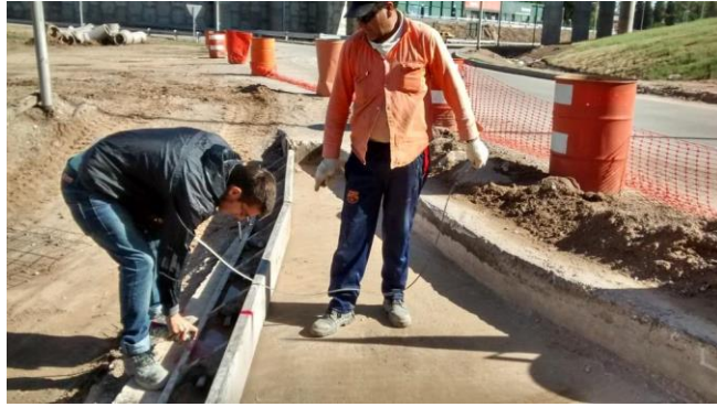
5.55 Marcado de la ubicación de la cama de Pasadores (junta)
