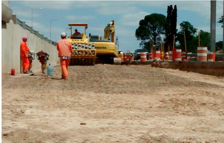
5.23 Compactado del material con Rodillo Pata de Cabra Vibratorio
