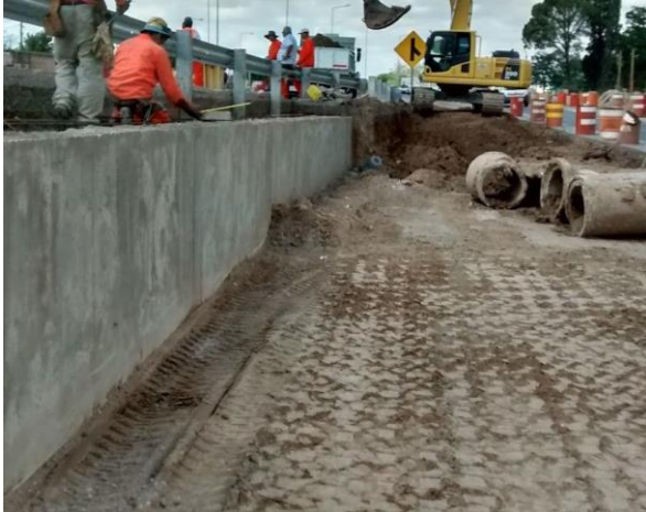
5.20 Exceso de humedad en la Subrasante contra muro de contención
