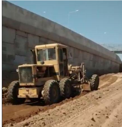
5.3 Motoniveladora realizando mezclado de la capa
