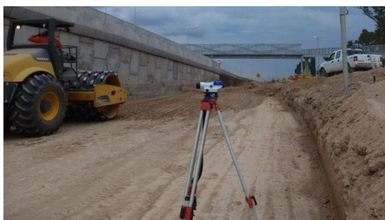
5.32 Banquina Derecha a sellar para conducir el agua hacia la alcantarilla
