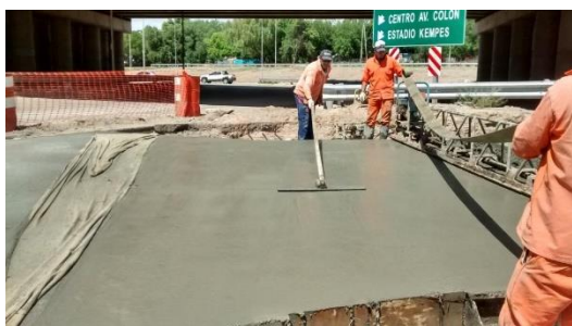
5.63 Alisado con Fratás y texturizado con faja y doble tela arpillera humedecida
