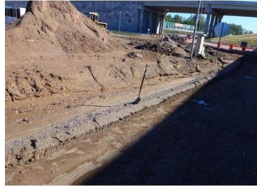
5.34 Estado de la Subbase luego de la Tormenta
