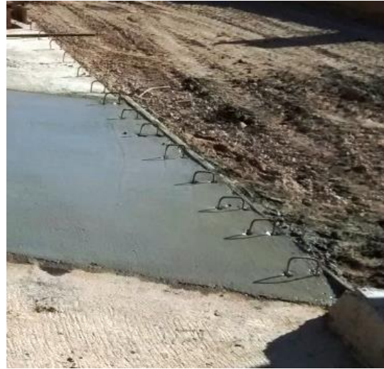
5.66 Armadura para futura construcción del Cordón
