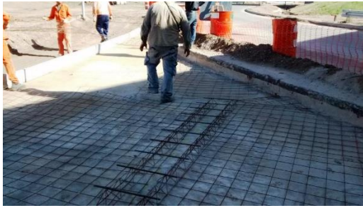
5.53 Presentación de las mallas metálicas, cama pasadores y barras de unión previo al colado
