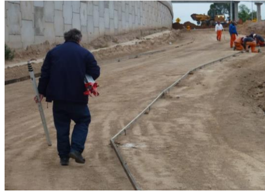
5.38 Encofrado para la Base de Hormigón H-8 Realizado con reglas y estacas de hierro
