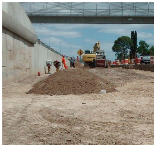
5.22 Material de subbase para distribuir
