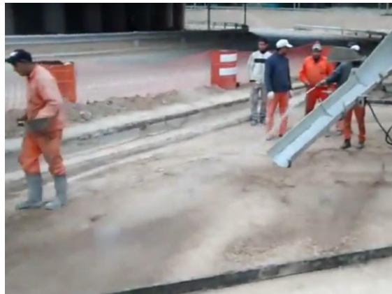
5.42 Humedecimiento de la Subbase
