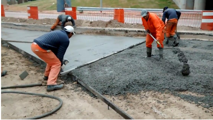
5.46 Operarios pasando la regla metálica para enrazar el material
