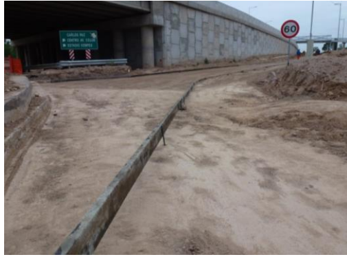
5.38 Encofrado para la Base de Hormigón H-8 Realizado con reglas y estacas de hierro
