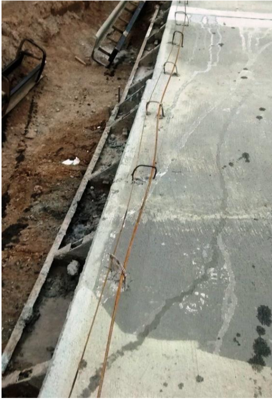
5.66 Armadura para futura construcción del Cordón
