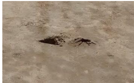
5.18 solape (izquierda) y bache (derecha) en la base de asiento
