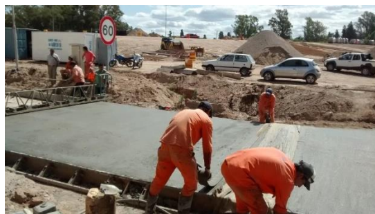
5.63 Alisado con Fratás y texturizado con faja y doble tela arpillera humedecida
