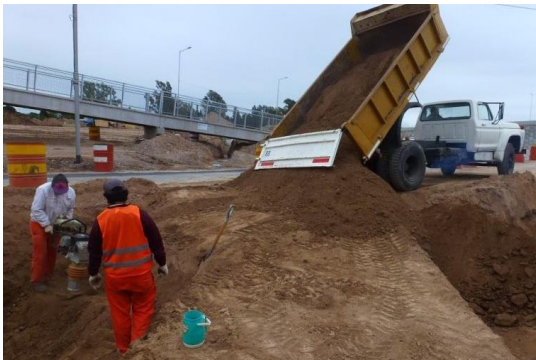
5.16 Volcado, distribución y Compactación de la mezcla suelo-cemento
