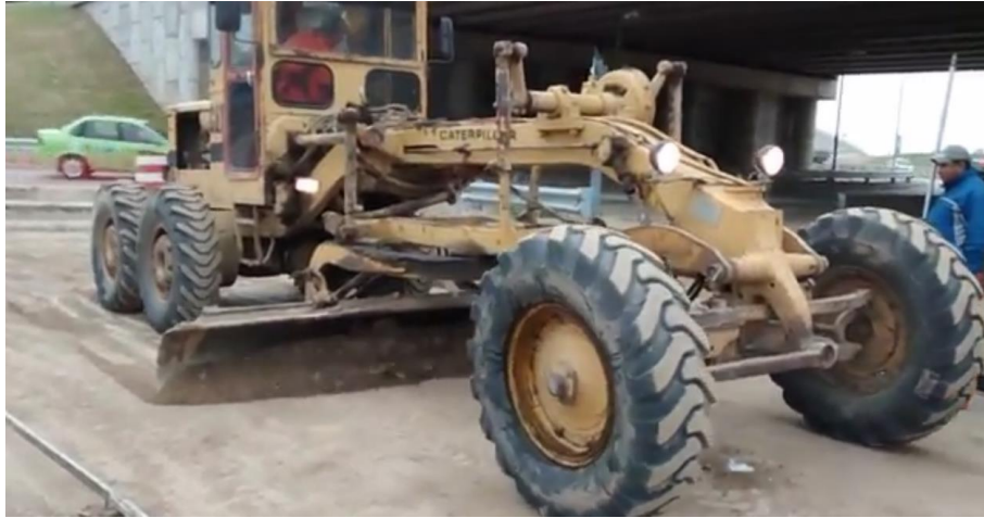
5.41 Motoniveladora realizando el corte de la Subbase
