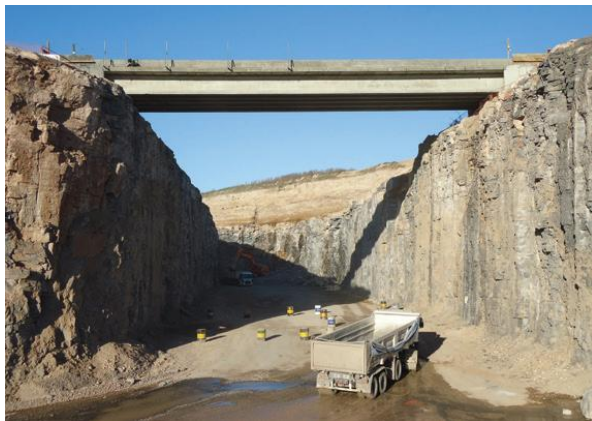
Figura 16: Vista general del puente
