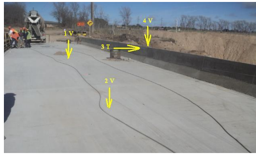
Figura 19: Ubicación de los sensores para la evaluación dinámica
