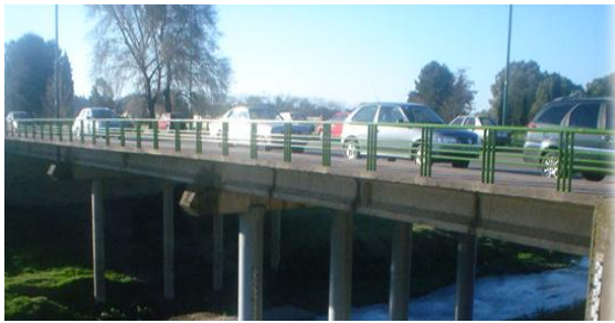
Figura 7: Vista del Puente Trabajadores.
