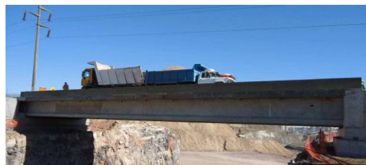
Figura 18: Instancia de la Prueba de Carga con 4 camiones (2do. Escalón de carga)
