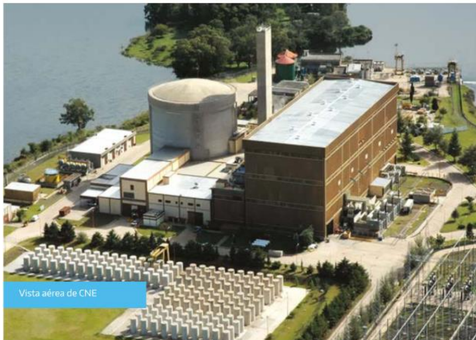
Figura 3.2.1.a: Vista aérea Central Nuclear Embalse. Fuente: Nucleoeléctrica Argentina S.A.
