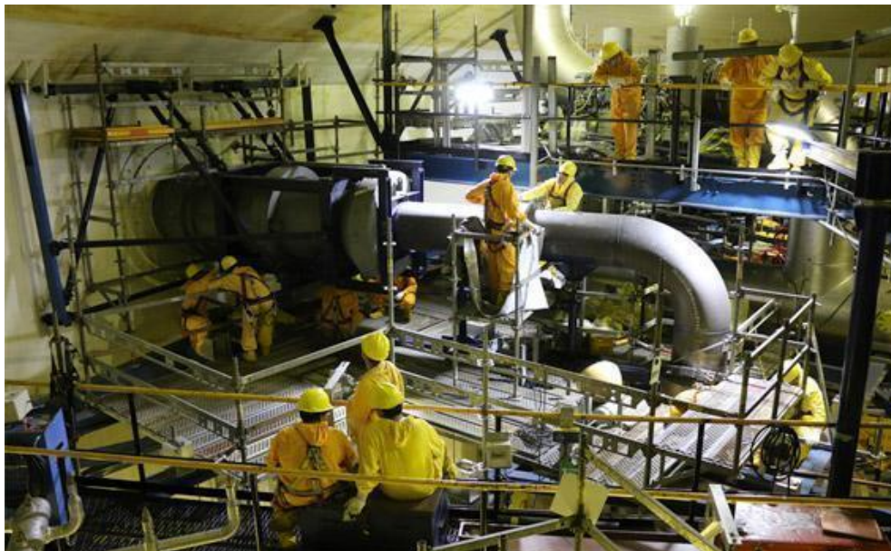
Figura 3.2.6.b: Trabajos dentro de Zona Controlada (ZC). Fuente: Nucleoeléctrica Argentina S.A.
