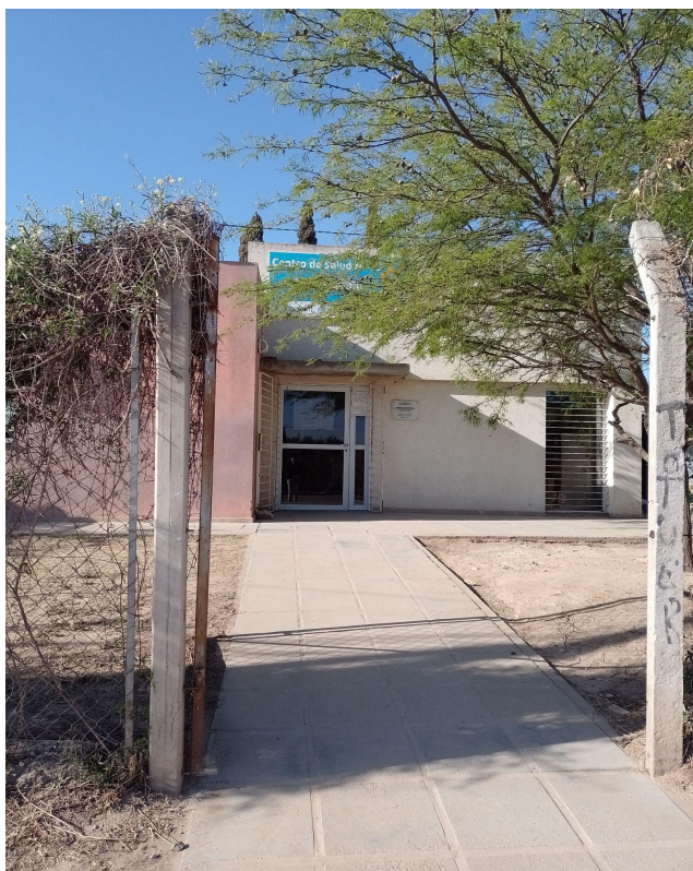
Imagen 2: La fachada del Centro de Salud
