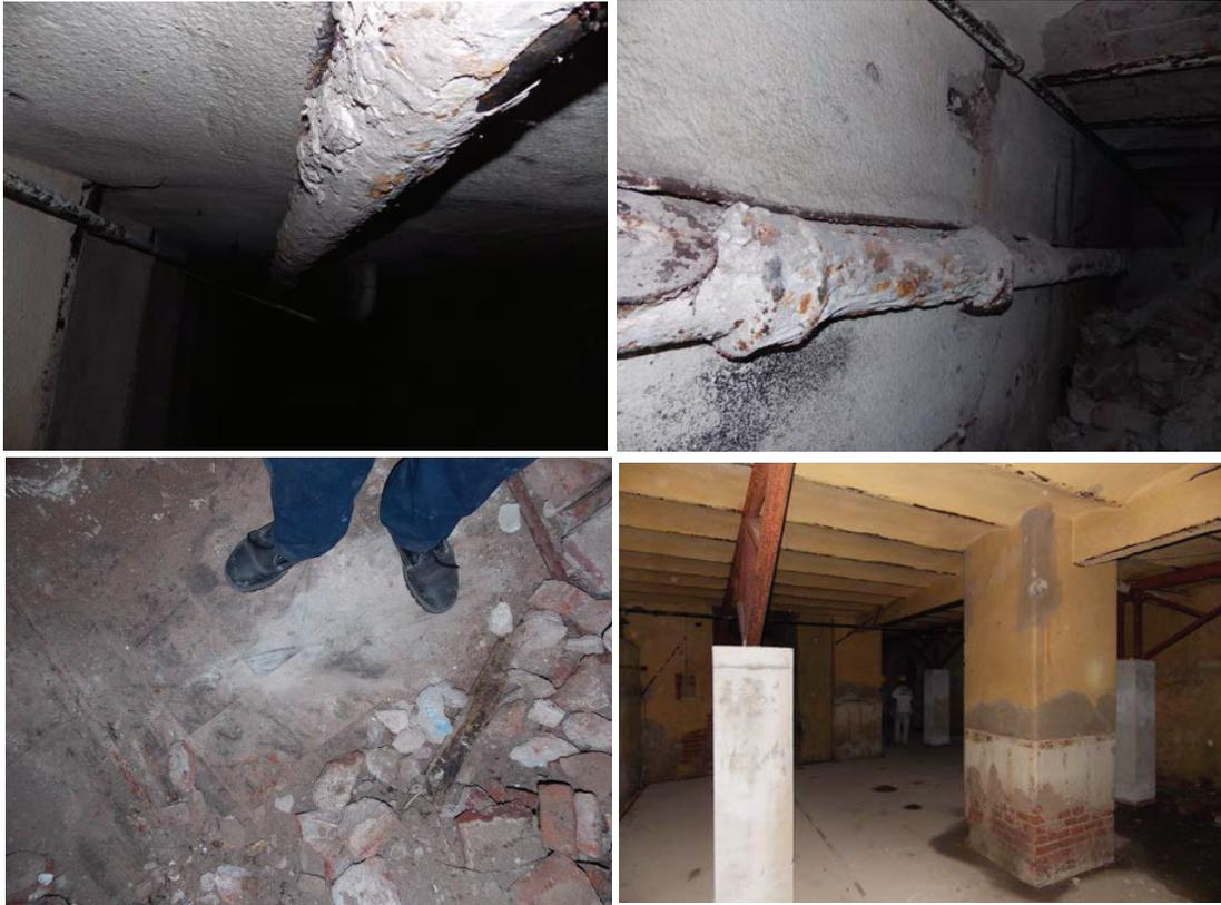
*Figura 5.2. Sótano del edificio en pie del Lote 2. Se pueden observar las cañerías de hierro que conectaban los baños con el sistema de cloaca, el sistema de sostén del piso y una cantidad de escombros de una demolición previa que ocupaba parcialmente el espacio.*
