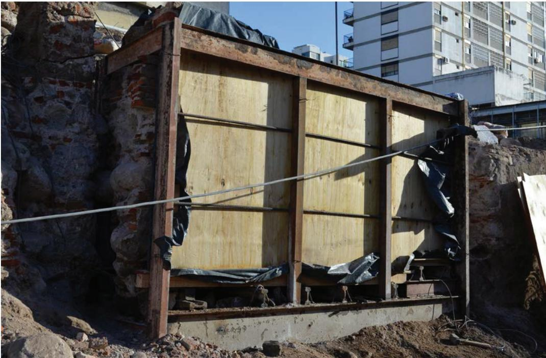
*Figura 12.19. Sector del muro listo para su extracción.*
