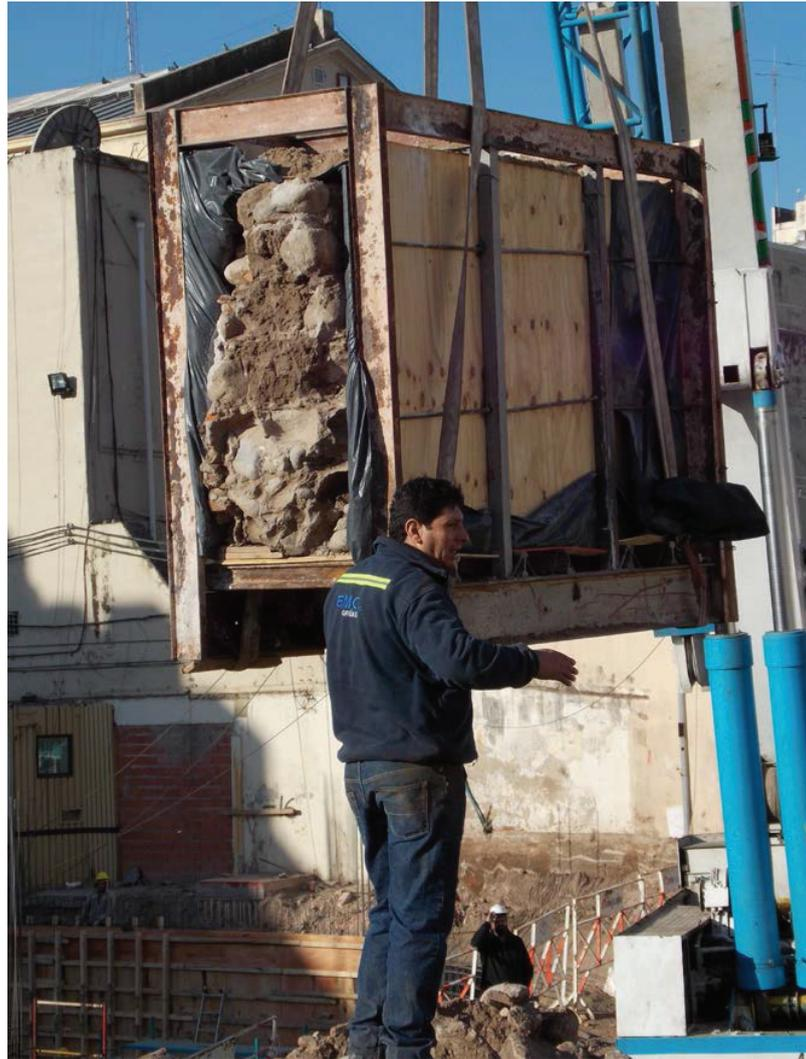
*Figura 12.24. Izado del primer sector del muro Puede observarse su integridad estructural.*
