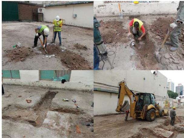
**Figura 6.3.** Comienzo de las actividades en el lote 3. En primera instancia se planteó la excavación con pico y pala, imagen de arriba a la izquierda, luego se utilizó martillo neumático para remover la primera capa y se continuo utilizando herramienta manual, foto de arriba a la derecha y abajo a la izquierda; para por último remover todo el estrato con maquinaria pesada, foto de abajo a la derecha
