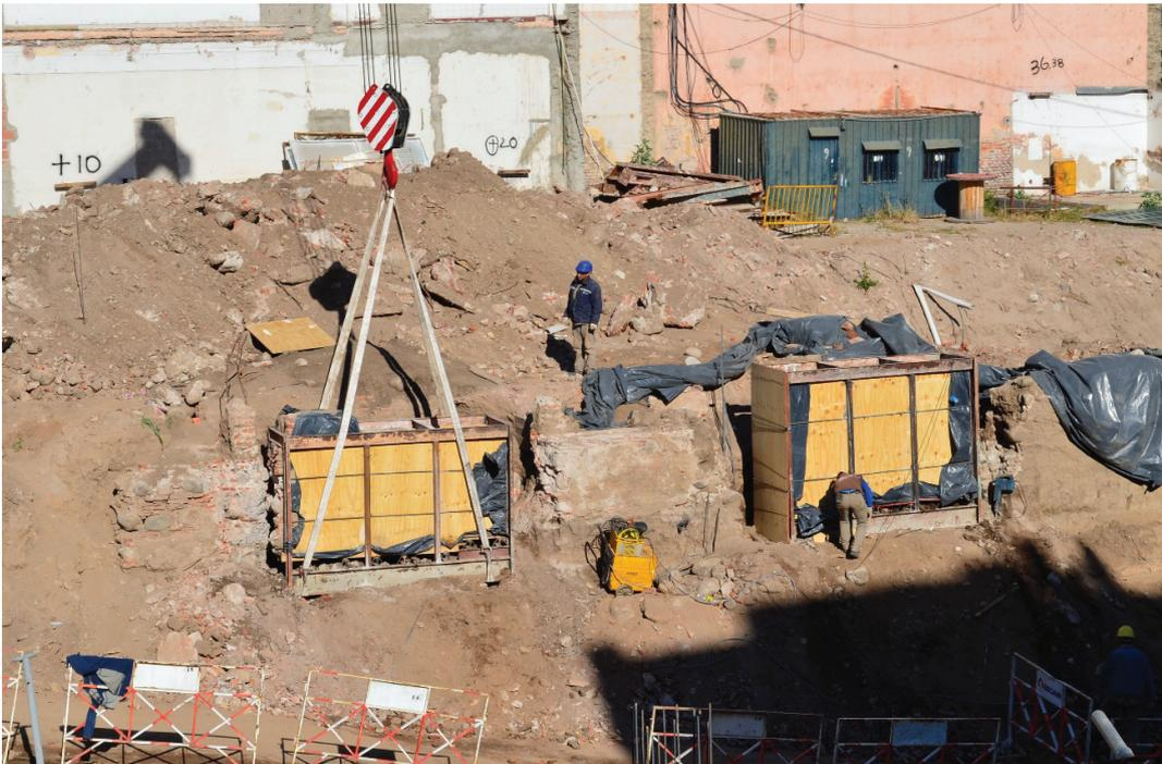
*Figura 12.23. Armazón completo listo para ser izado.*
