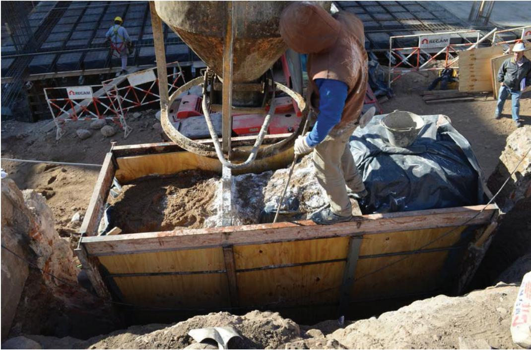
*Figura 12.18. Detalle de la tolva y del sistema de confinamiento con fenólicos.*
