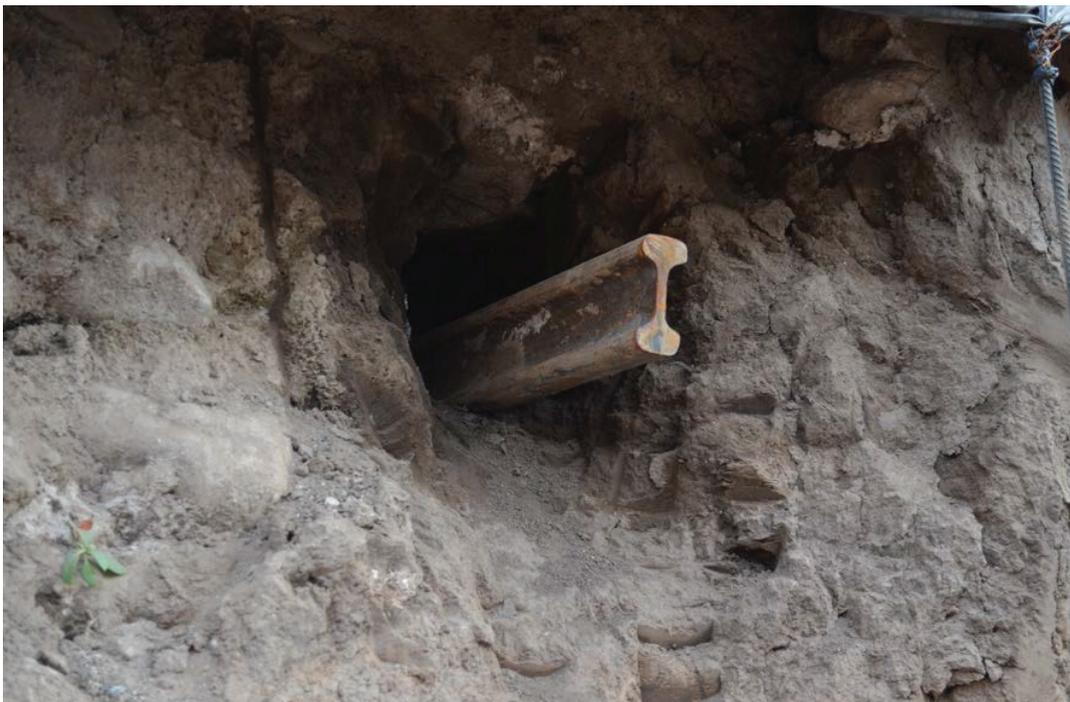
*Figura 12.9. Perfil IPN 12 presentado por debajo del muro.*
