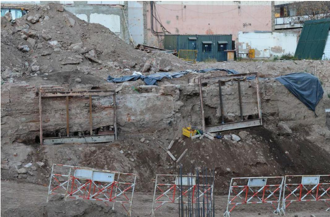
*Figura 12.15. Los dos sectores del muro con sus armazones finalizados y listos para su confinamiento final y remoción.*
