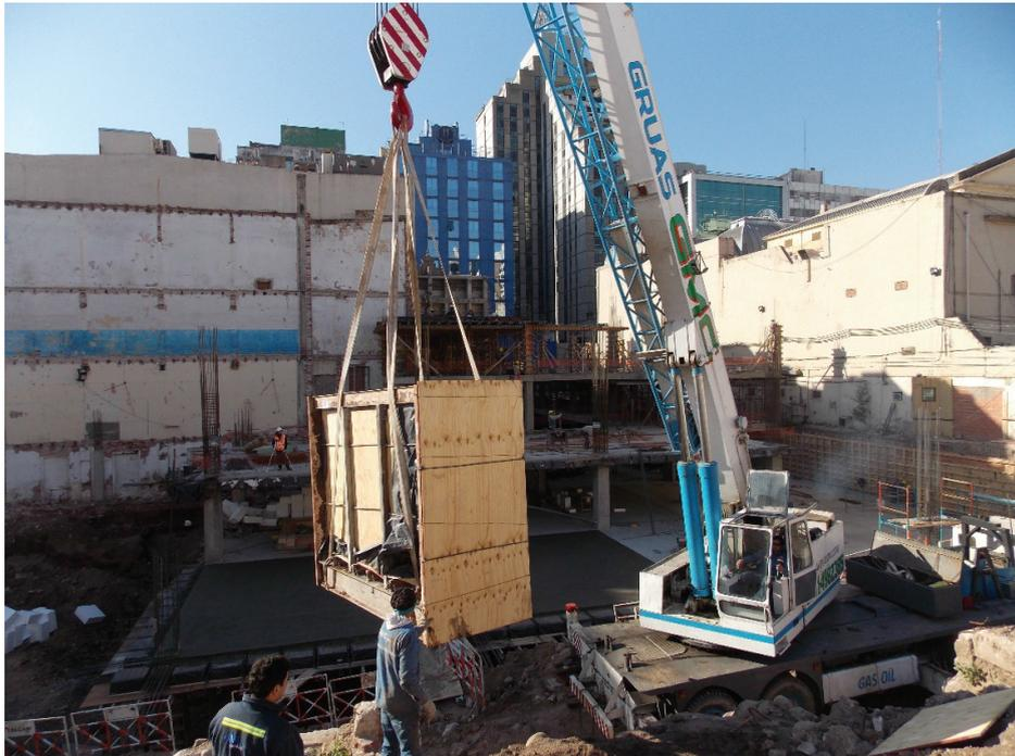
*Figura 12.27. Extracción del segundo sector del muro.*
