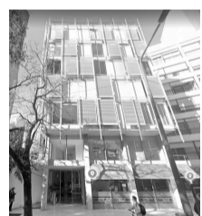
06 Edificios de Oficinas
