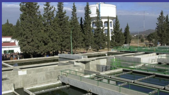
Figura 7.1.28- Planta potabilizadora de agua La Calera.
