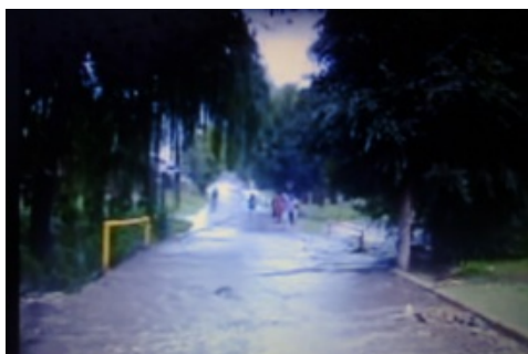
Figura 7.1.51 Crecida del arroyo en año 2000.
