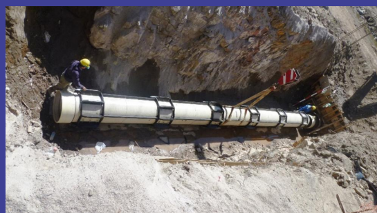
Figura 7.1.31- Planta potabilizadora de agua La Calera.
