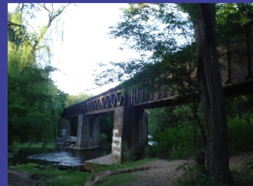
1- CRUCE CORREDOR FERROVIARIO.
