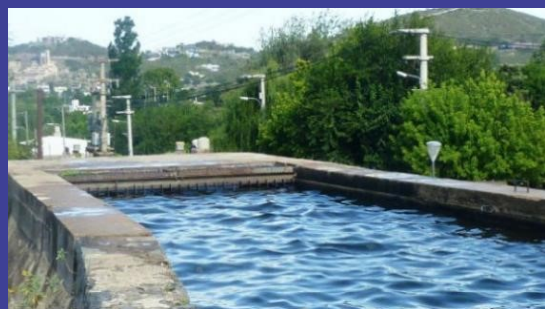
Figura 7.1.30- Planta potabilizadora de agua La Calera.
