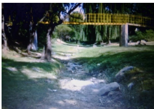
Figura 7.1.52 Imagen del puente construido como resultado de la prevención de crecidas del A° La Mesada.
