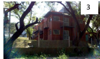
Figura 7.2.31 Vivienda agrupada (Complejos).
