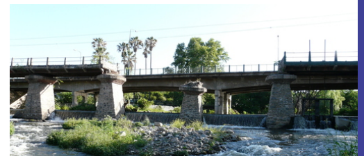
Figura 7.1.48 Vista hacia el Puente de los Suspiros después de la inundación histórica en el año 2000.
