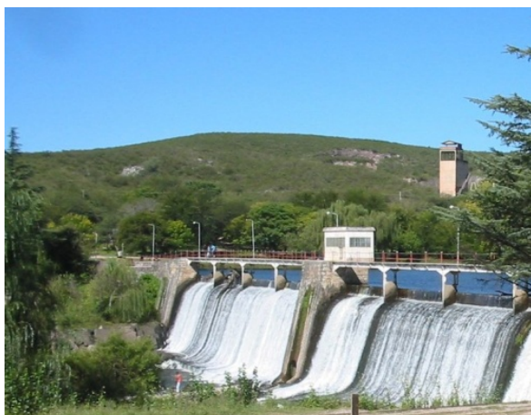
Figura 6.2: Dique Mal Paso.
