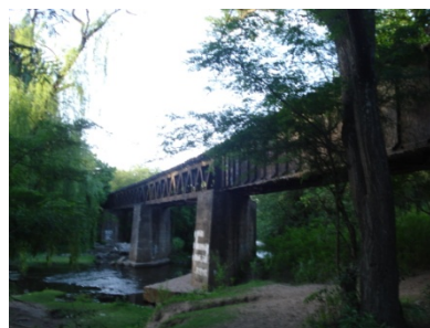
Cruce vías FFCC.
