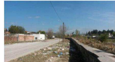
Los bordes se encuentran contaminados
