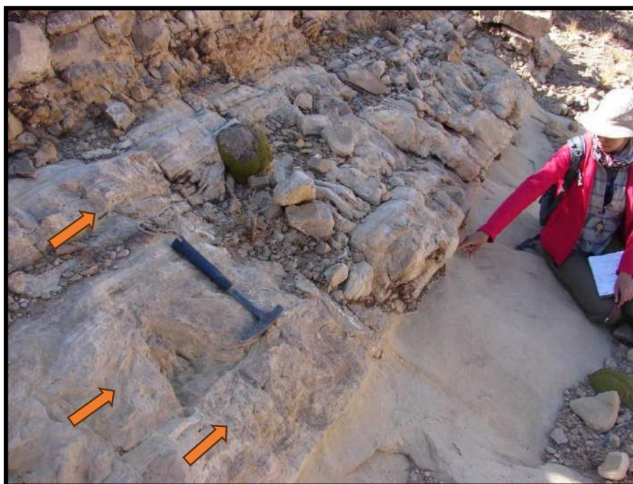
Figura 3.2. Adquisición de datos de campo, con la medición de espesores, recolección de muestras y construcción de perfiles estratigráficos. En esta imagen, pueden verse en primer plano, estratos medianos de calcarenitas arenosas, afectados por intensa deformación sinsedimentaria (flechas naranjas) pertenecientes a la sección inferior de la Formación Yacoraité en el Espinazo del Diablo.
