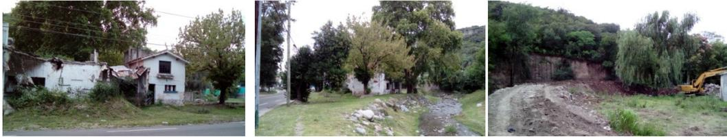
*Figura 127.* Destrucción de construcciones próximas al río sobre la avenida. Incorporación de algunos taludes-barrera adyacentes al curso de agua. (tramo norte)
