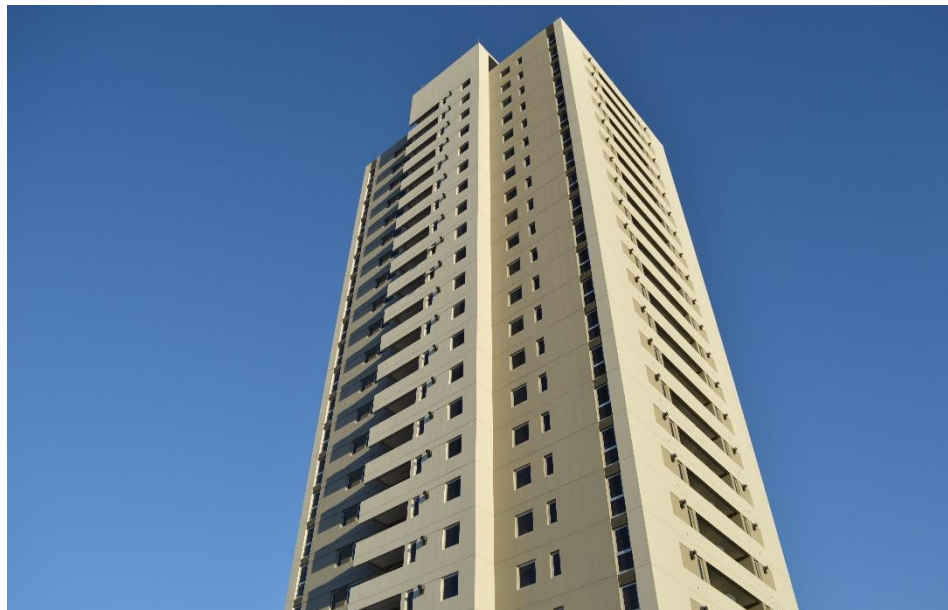
Imagen 1: torre de departamentos en construcción, Córdoba. Fuente: elaboración propia
