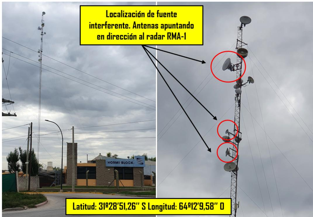
Figura 4.11: Localización de posible fuente de interferencia en una dirección acimutal específica (grupo de interferencias número 1).
