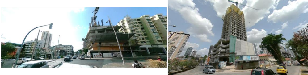
Ilustración 71: Registro fotográfico (calles 42,43 y 44).
