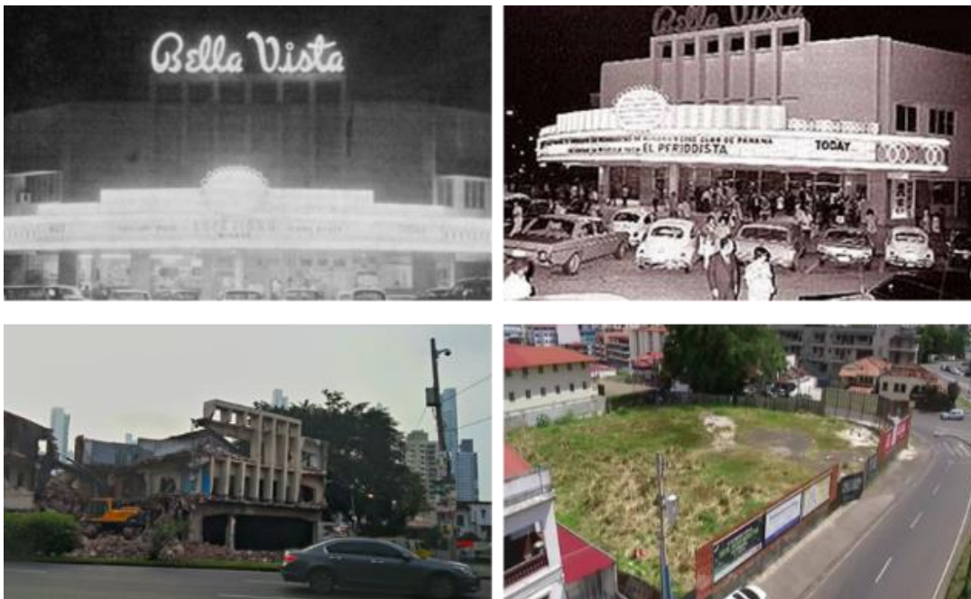
Teatro de Bella Vista, demolición en el 2013. Actualmente es un lote baldío
