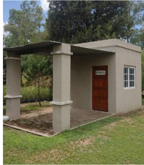
Fig. 24. Depósito de insumos y productos fitosanitarios. Fuente: Elaboración propia, 2022.
