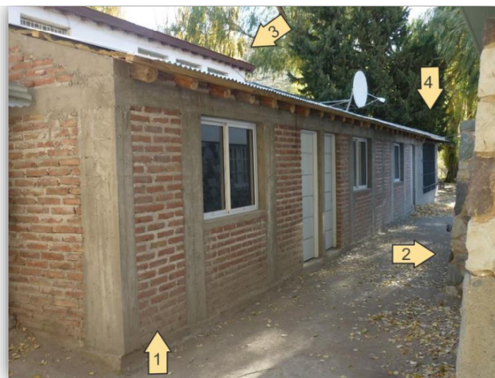
Figura 19. Aulas nuevas Escuela de Bardas Blancas
