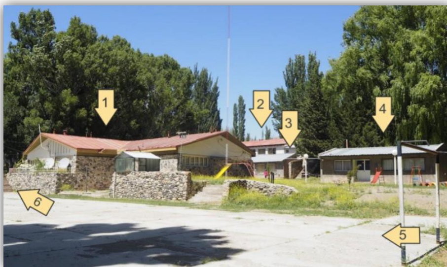
Figura 17. Edificios de la escuela, observados desde el playón deportivo
