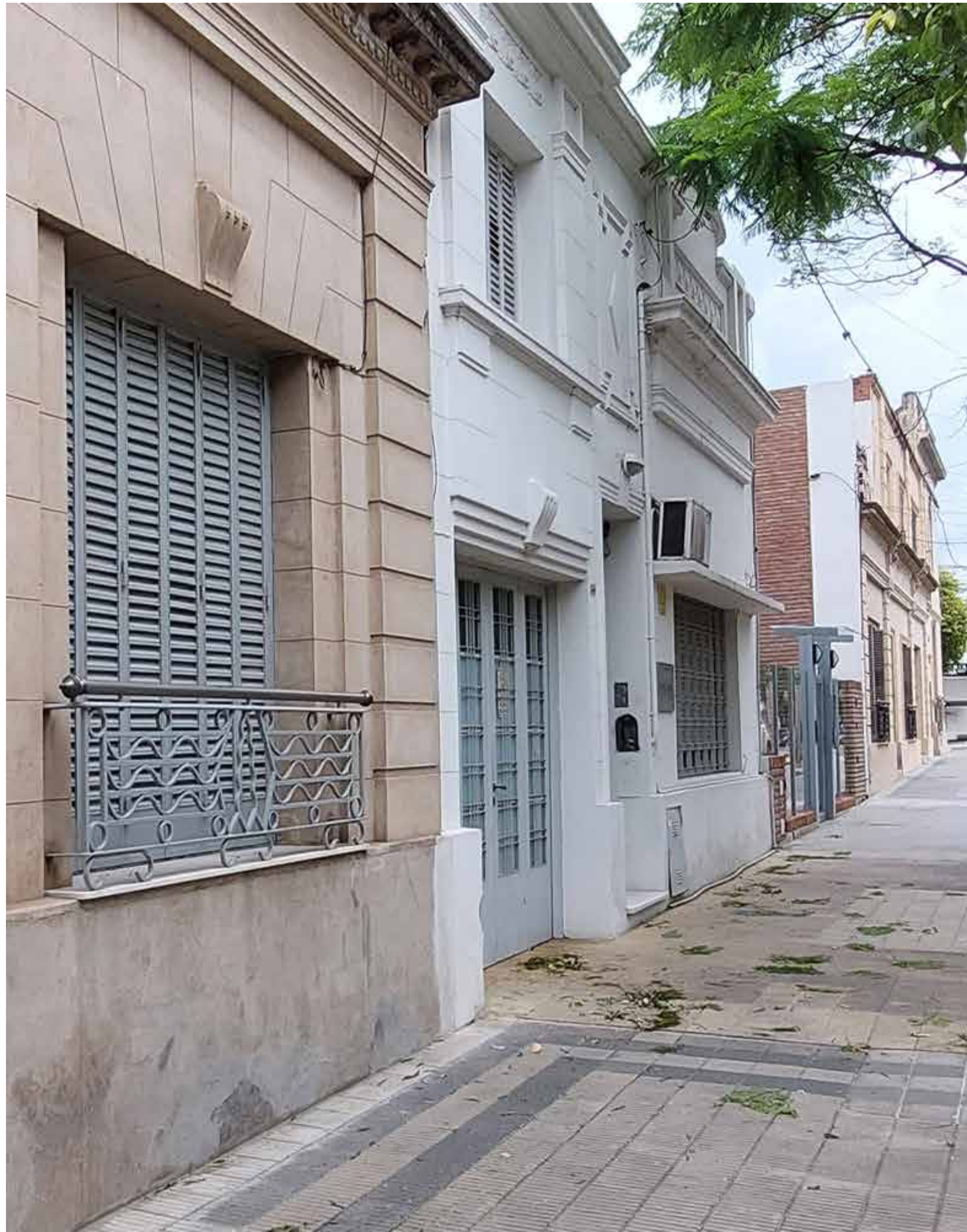
• El conjunto con el nuevo edificio 2022 PH L. Samar
