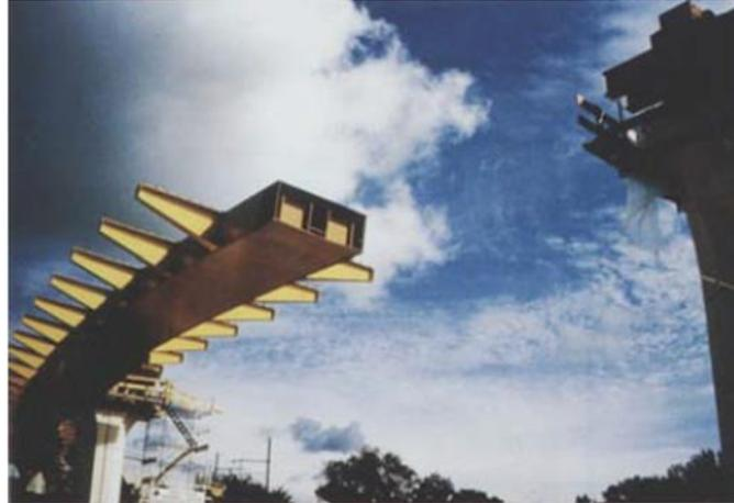
**Figura 2-1.** Secciones con voladizos laterales
