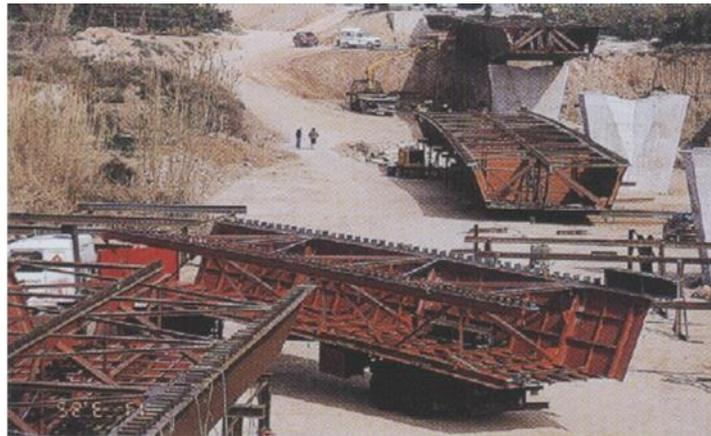
**Figura 2-2** Tramos de sección y ensamblaje en obra
