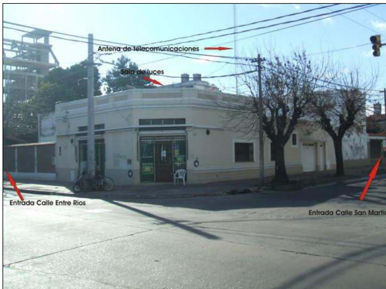
Figura 2. Vista desde el exterior de la ex R.I.B.A.
