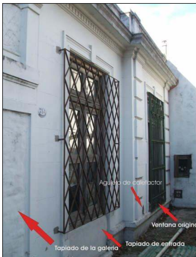
Figura 11. Vista de Fachada de la casa chorizo.
