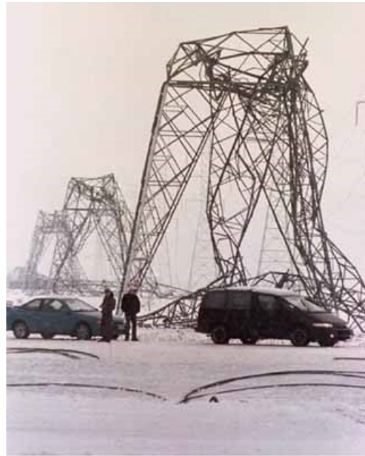
(b) Daños caóticos debido al Galloping
