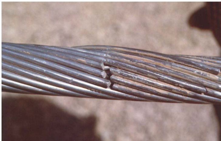
Figure 3.6: Falla de la capa externa, debido a niveles de esfuerzos de flexión excesivos [9]
