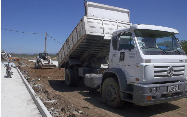
Figura 4.15 - Limpieza de traza para zanjeo.
