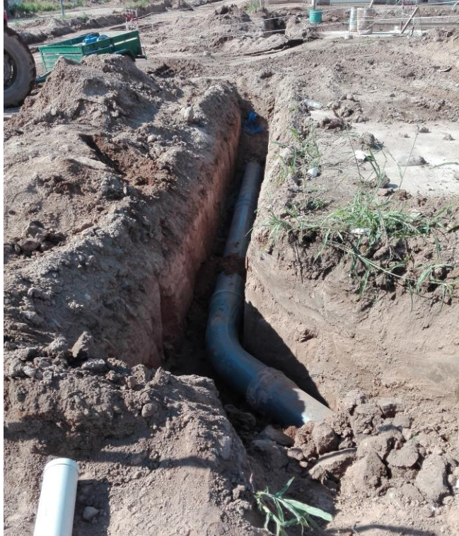
Figura 5.33 - Tendido de cañería PVC C10 DN 315mm de empalme a la cámara de medición.
