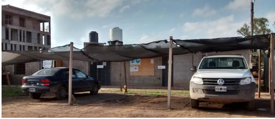
Figura 4.3 - Edificio con comedor, vestuarios, laboratorio y oficinas.
