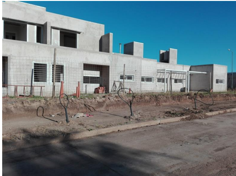
Figura 5.28 - Tendido de conexiones largas domiciliarias.
