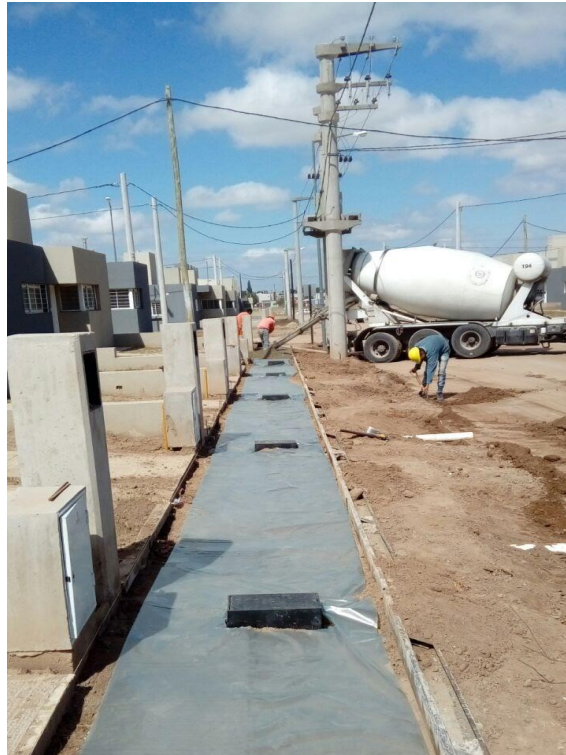
Figura 5.29 - Colocación de cajas de medidores y hormigonado de veredas.
