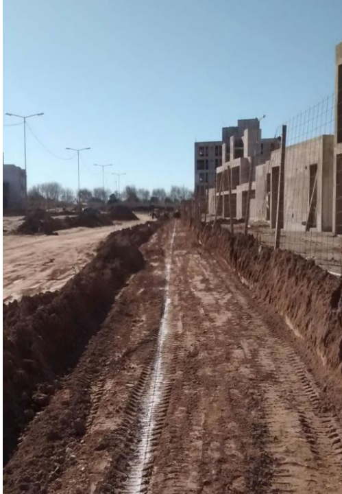
Figura 4.16 - Vereda preparada y a nivel, con trazado de línea de cal para posterior zanjeo.
