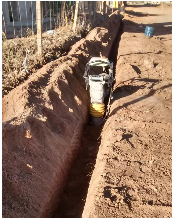
Figura 5.7 - Se compactan las capas con compactador manual.
