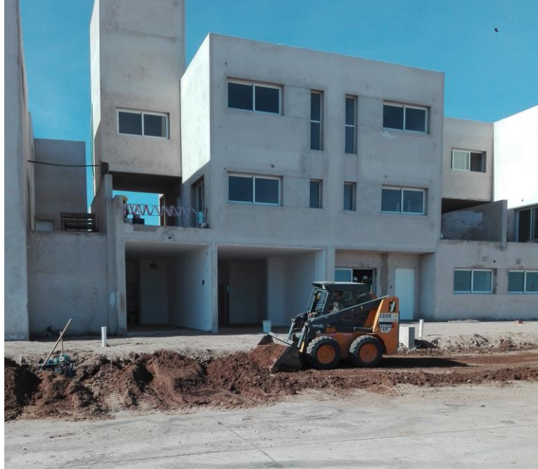
Figura 5.8 - Nivelación a nivel de vereda de la zona de trabajo.
