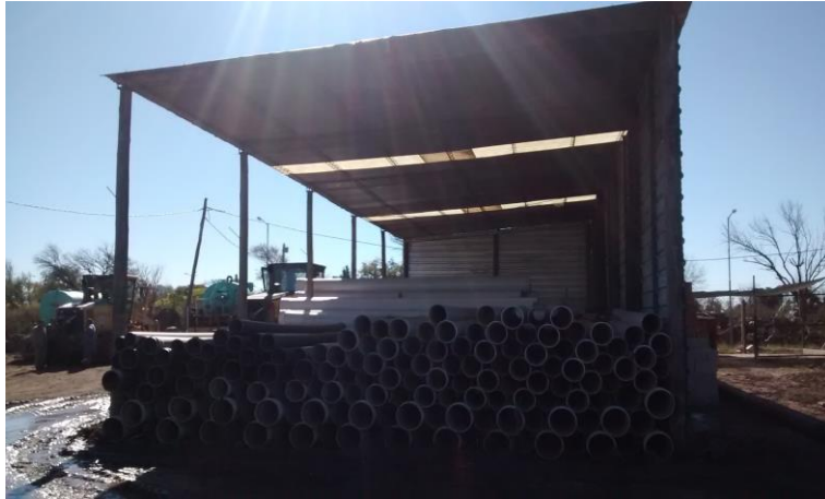
Figura 4.4 - Depósito de caños de mayor DN.
