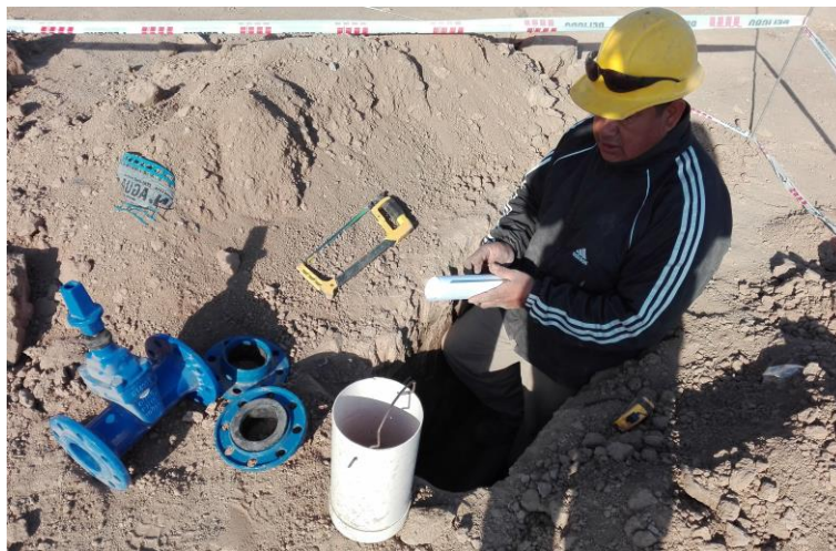
Figura 5.11 - Operario colocando una válvula esclusa
