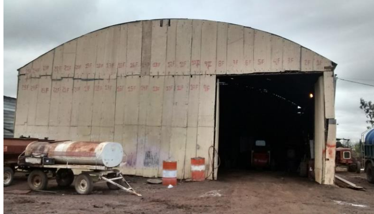
Figura 4.7 - Vista frontal de Galpón N°1.
