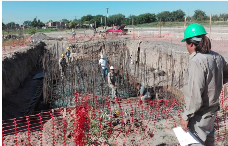
Figura 5.34 - Construcción de cámara de bombeo
