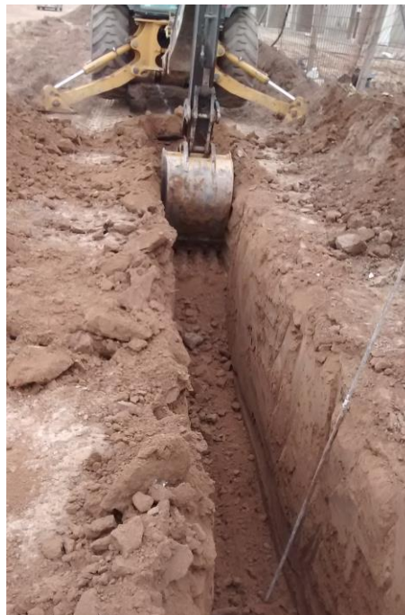
Figura 5.2 - Excavación con retroexcavadora para diámetros nominales mayores a 110mm
