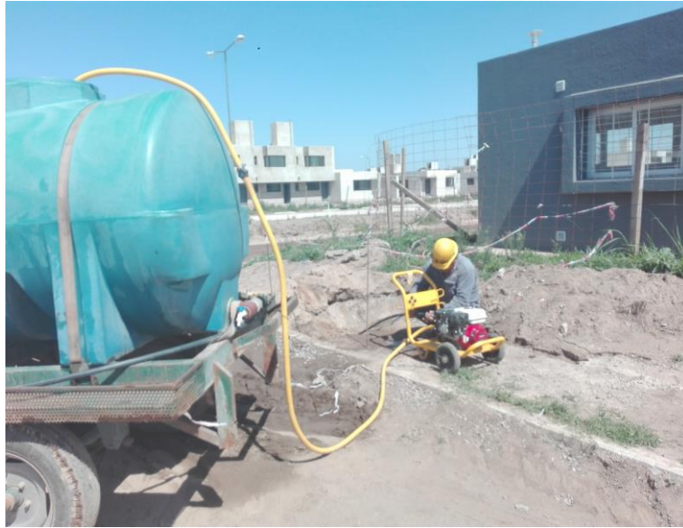
Figura 5.30 - Llenado de cañería para prueba hidráulica parcial.
