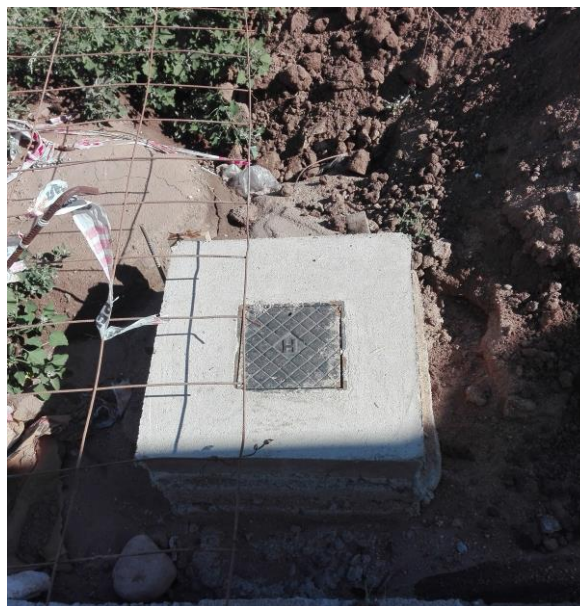
Figura 5.17 - Cámara de Hidrante terminada
