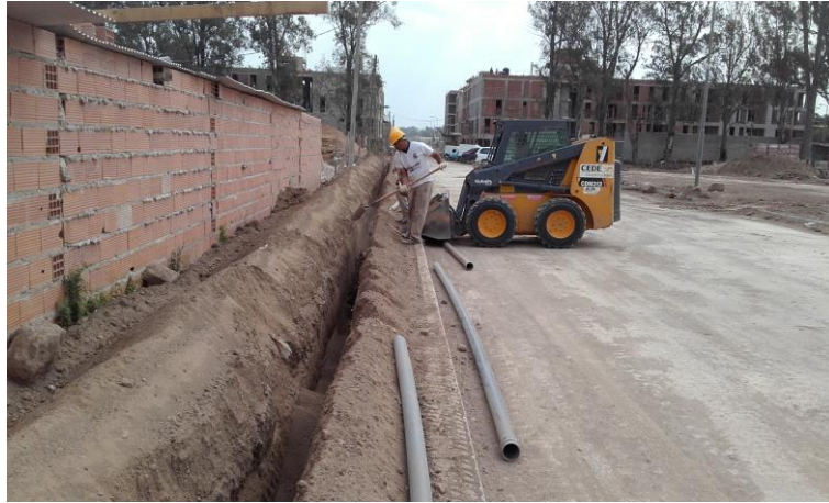
Figura 5.3 - Relleno de fondo de zanja con arena.
