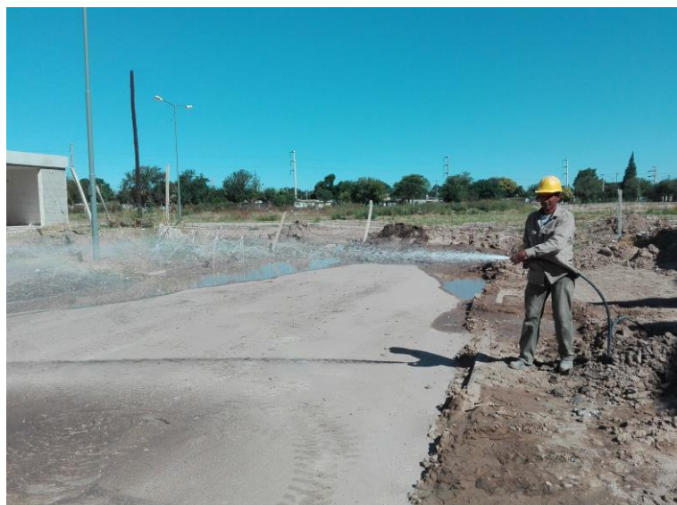
Figura 5.32 - Descarga de presión de cañería de PVC de uno de los tramos de DN 90mm.
