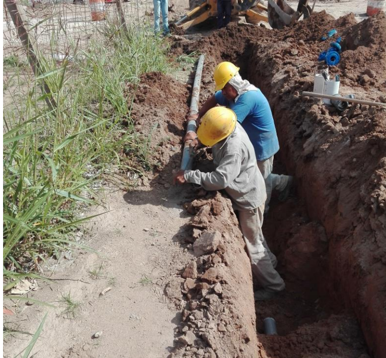
Figura 5.4 - Operarios conectando los caños que conforman la red.
