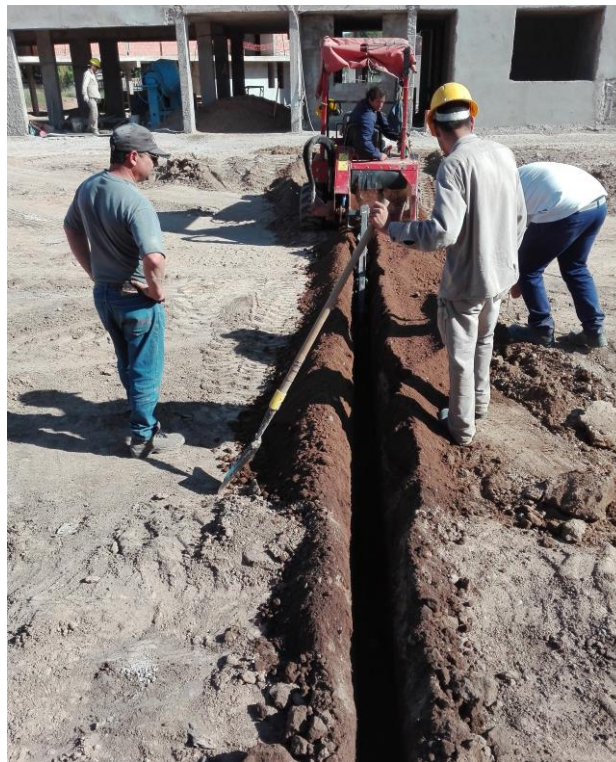
Figura 5.26 - Ejecución de conexiones domiciliarias largas.
