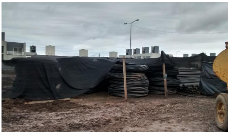
Figura 4.6 - Acopio de manguera de PEAD.
