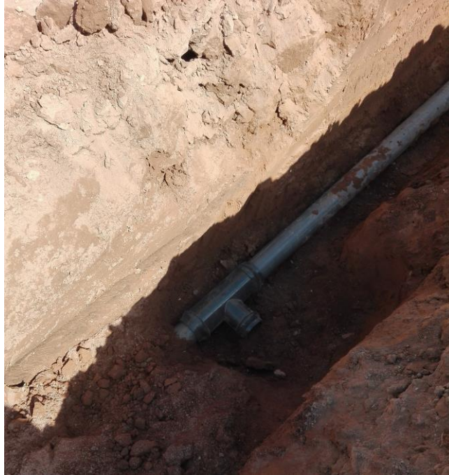
Figura 5.15 - Colocación de ramal simple para derivación hacia el Hidrante
