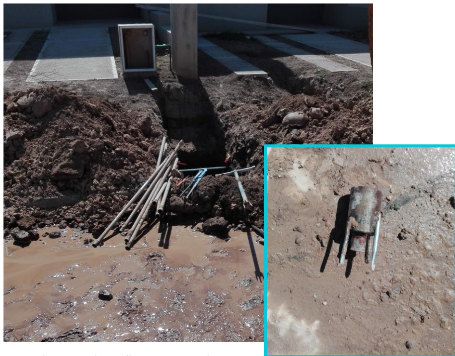
Figura 5.27 - Topo y sistema de caño para tunelera.
