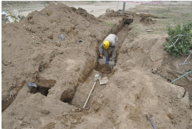
Figura 5.13 - Desencofrado de dado de anclaje para Válvula Exclusa tipo EURO 20.
