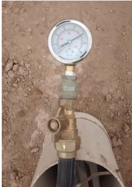
Figura 5.31 - Manómetro para control de presión.
