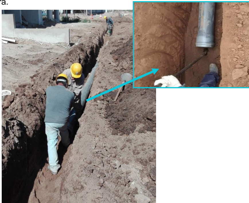
Figura 5.5 - Empleo de barreta para ejecutar el enchufe entre los caños.
