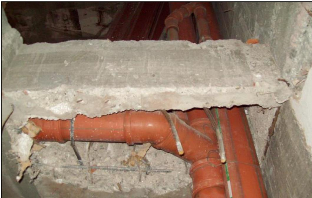
**Conexión a Cañería de Ventilación Principal mediante ángulo a 45°**
