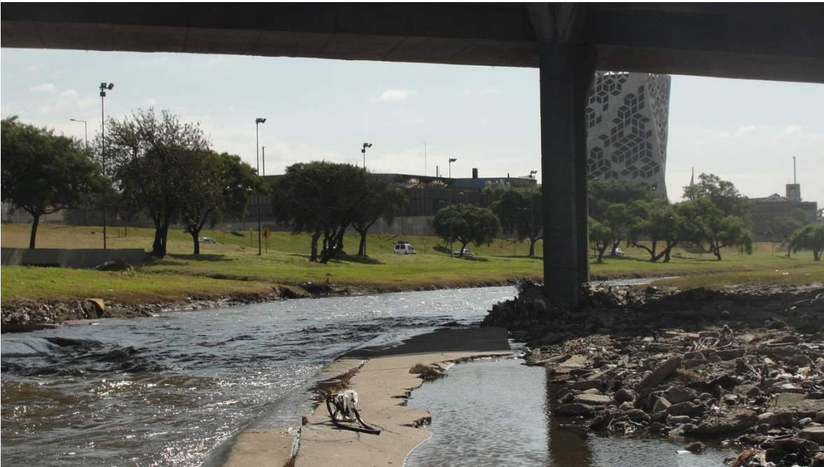
Figura 32: Vista hacia aguas arriba desde la curva analizada.
