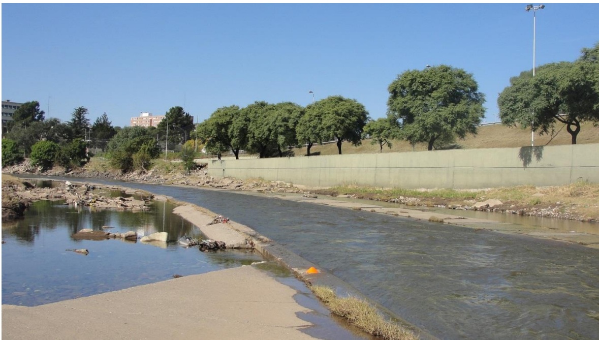
Figura 31: Canalización de la curva estudiada hacia aguas abajo
