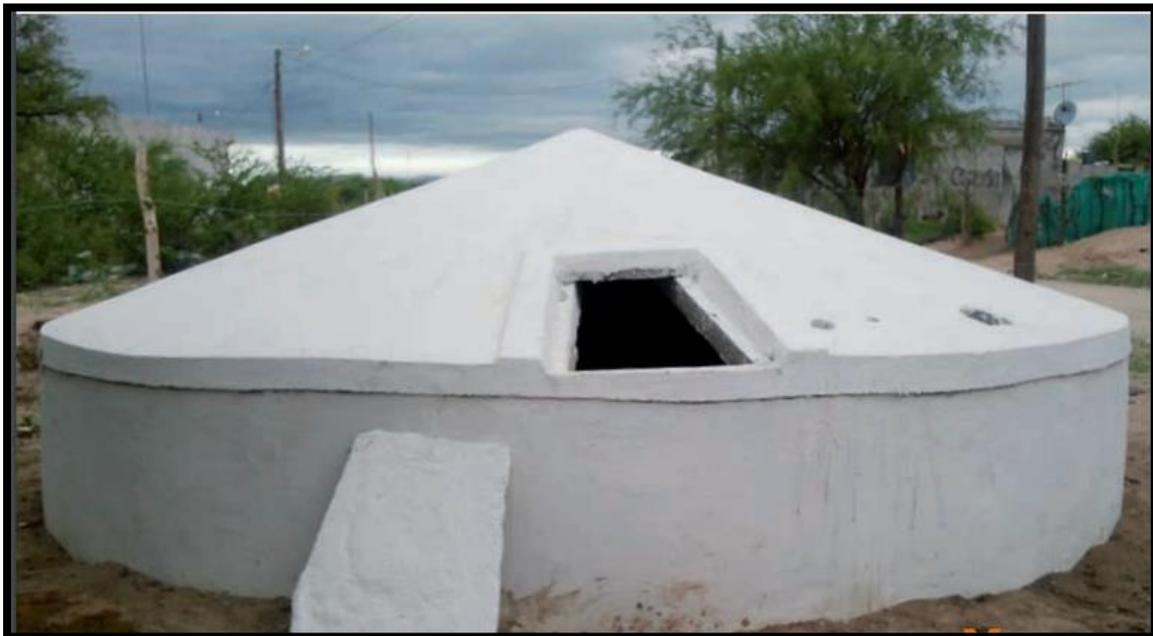
Ilustración 17 Cisternas de placa de ferrocemento desarrolladas para el semiarido brasileño (ASA)
