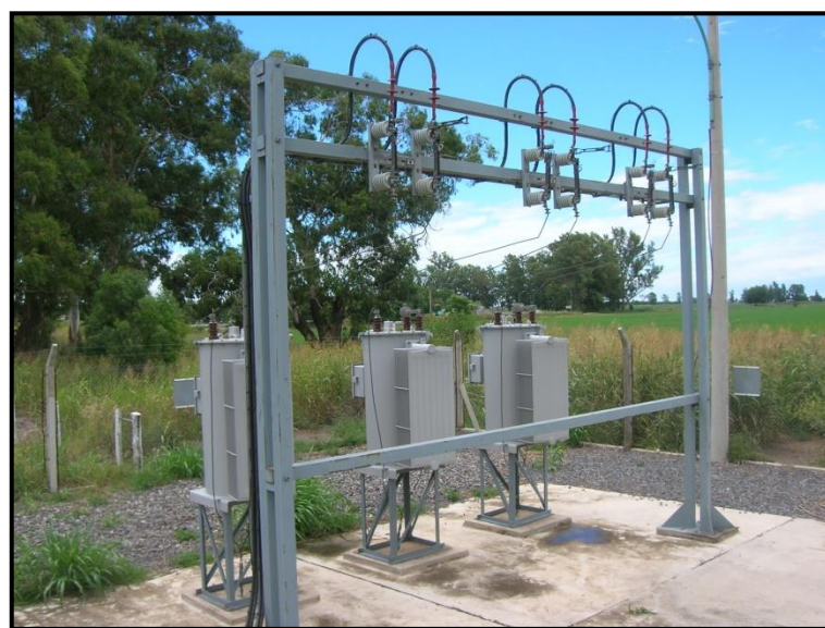
Figura 56. Montaje de reguladores sobre franja de servidumbre
