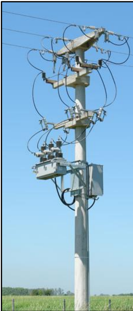
Figura 61. Reconectores trifásicos montados en postes
