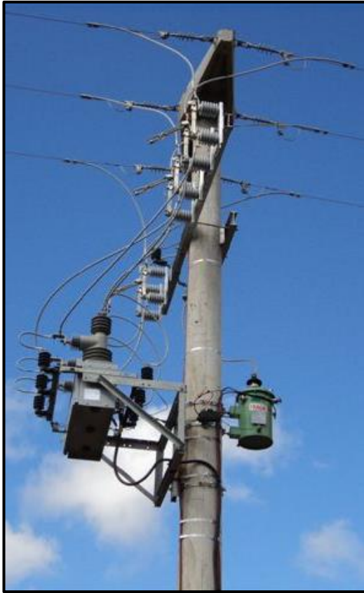
Figura 62. Montaje de reconectador en poste
