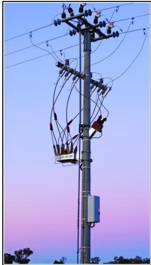
Figura 61. Reconectores trifásicos montados en postes
