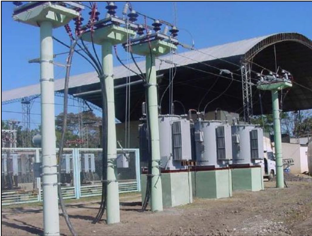
Figura 57. Montaje de reguladores de tensión en la Estación Transformadora
