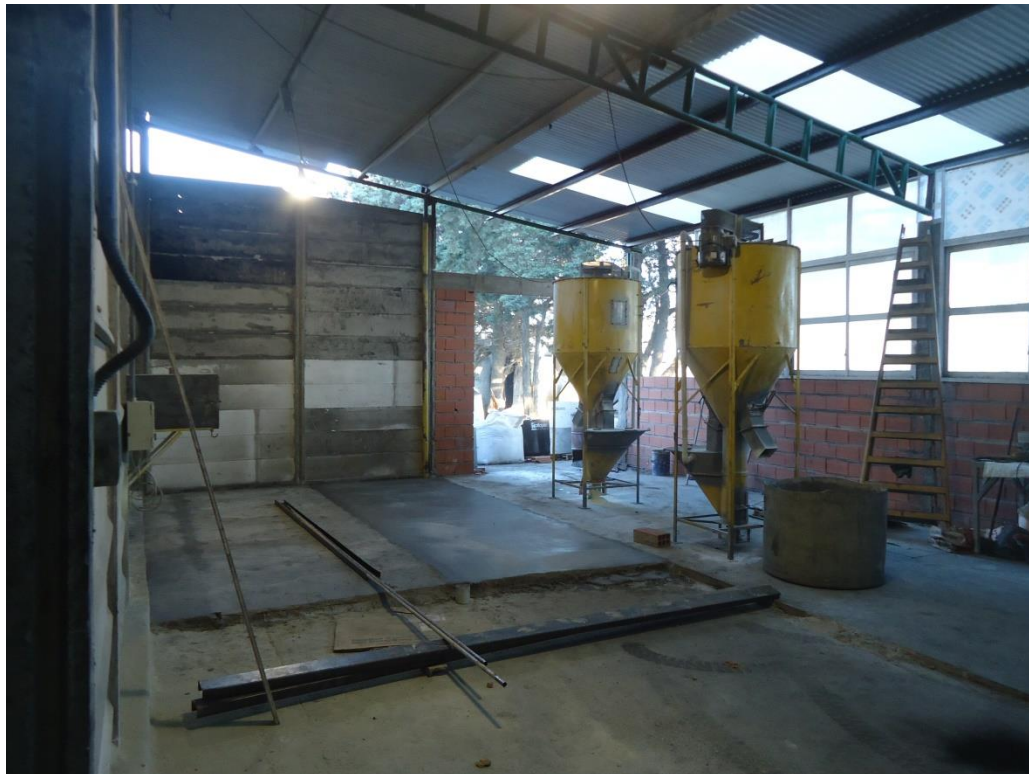
Imagen 28: obra en construcción, sector de mezclado.
