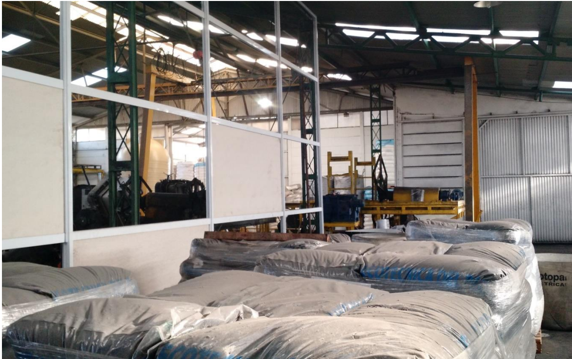
Imagen 33: incorporación del sector 4 al sector de inyectora. En proceso.
