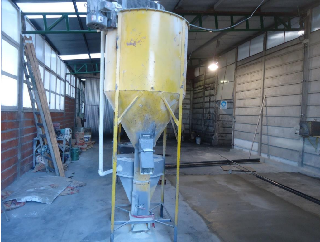
Imagen 29: obra en construcción, sector de mezclado.
