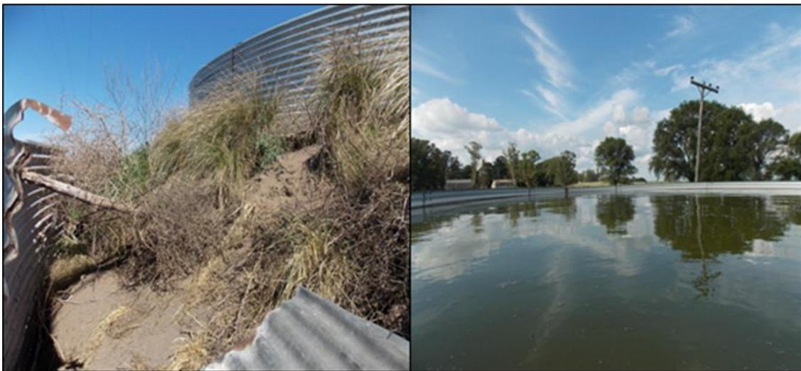
Figura 35: Terraplén con excesiva pendiente (izq.) lo que causo desmoronamiento y disminución en la capacidad de almacenamiento del tanque (der.)
