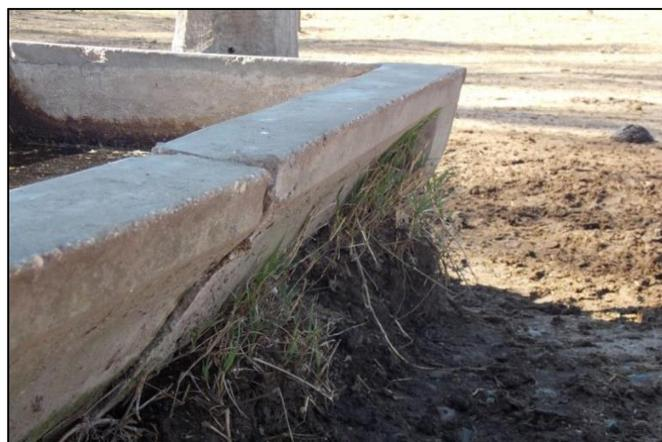
Figura 33: Aguada con roturas causando pérdidas y formación de barro.
