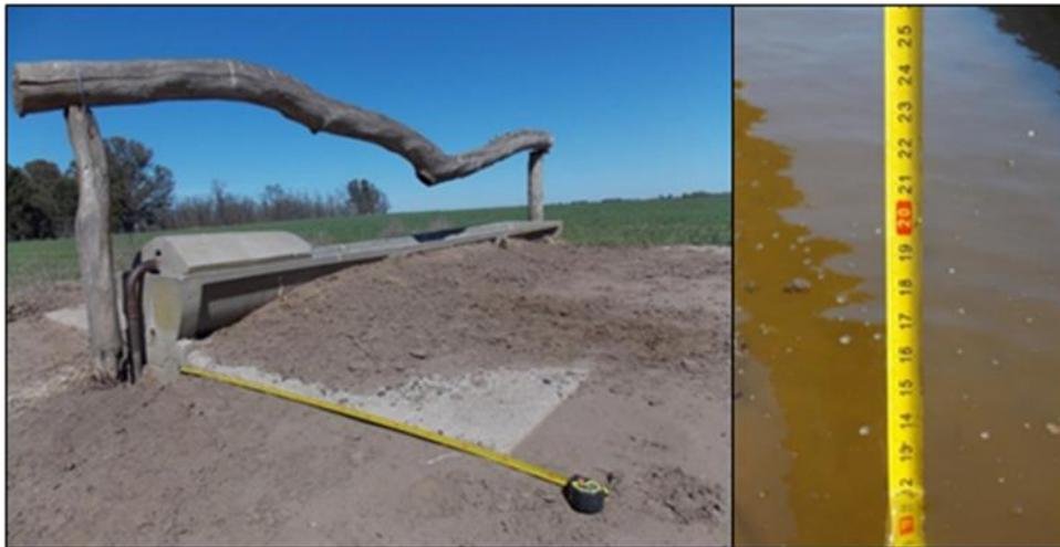
Figura 32: Aguada con vereda (1,5 m) y profundidad de agua (12 cm) inadecuados.
