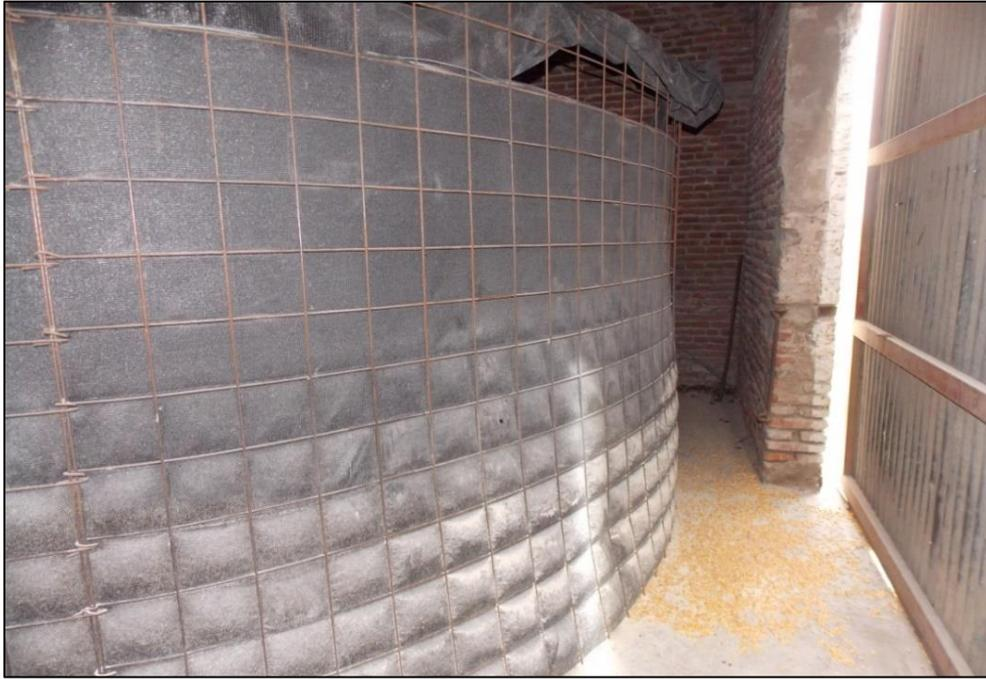
Figura 36: Silo de malla cima con capacidad para almacenar 40 Ton de grano de maíz.
