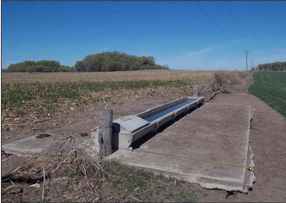
Figura 34: Aguada con dimensiones correctas pero con falta de terraplén.
