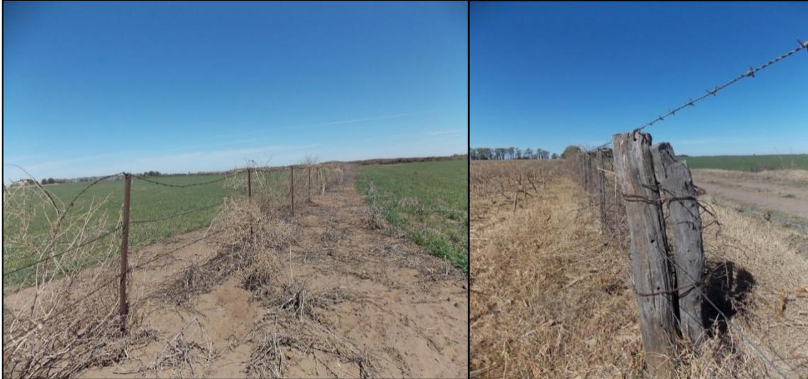
Figura 45: Alambrados en mal estado de mantenimiento, postes reforzados y líneas con alambre de púa.
