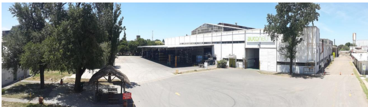
Figura 5-2 Instalaciones de AUTONEUM ARGENTINA. [Fotografía].
