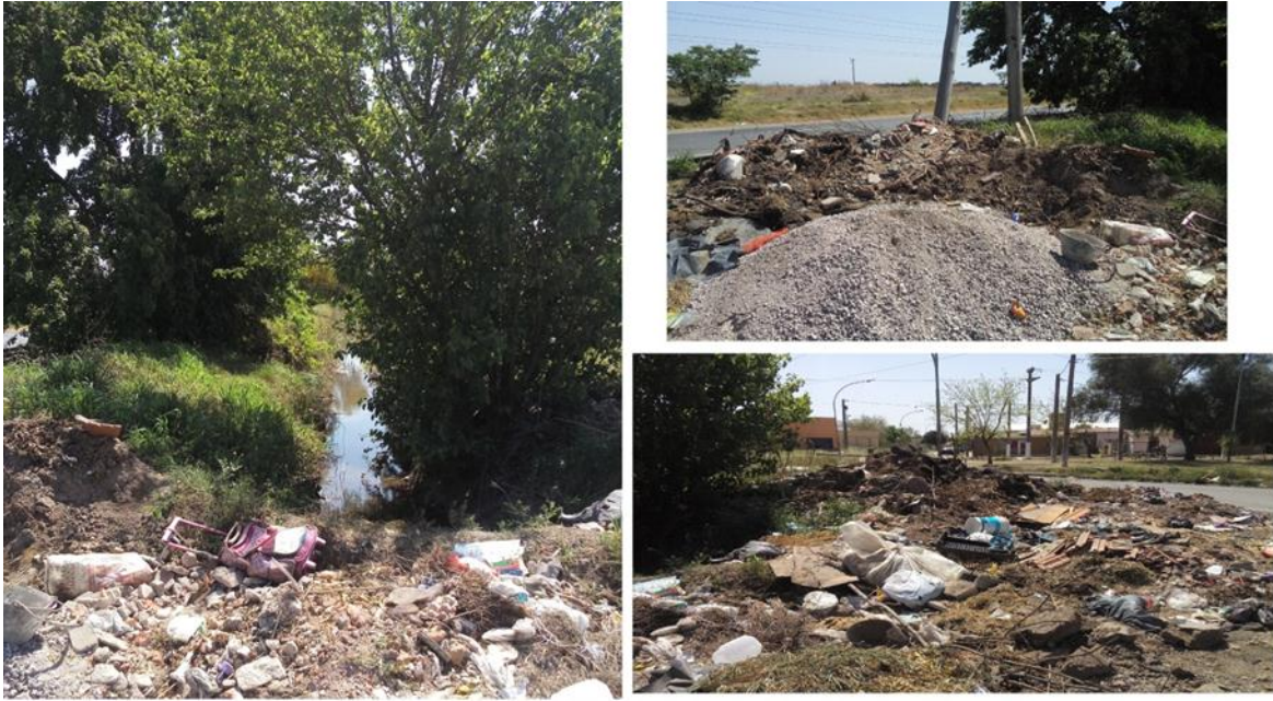
Figura 4: Estado de los canales aledaños a las urbanizaciones (Ciudad Mis Sueños).
