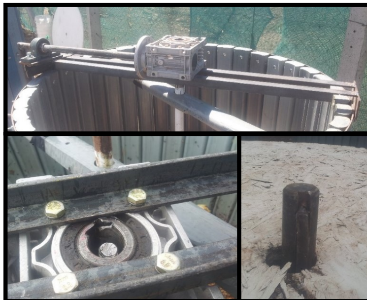
Fig. 2.14. Problemas mecánicos en el sistema de encastre móvil utilizado en el primer mecanismo de mezclado puesto a prueba.
