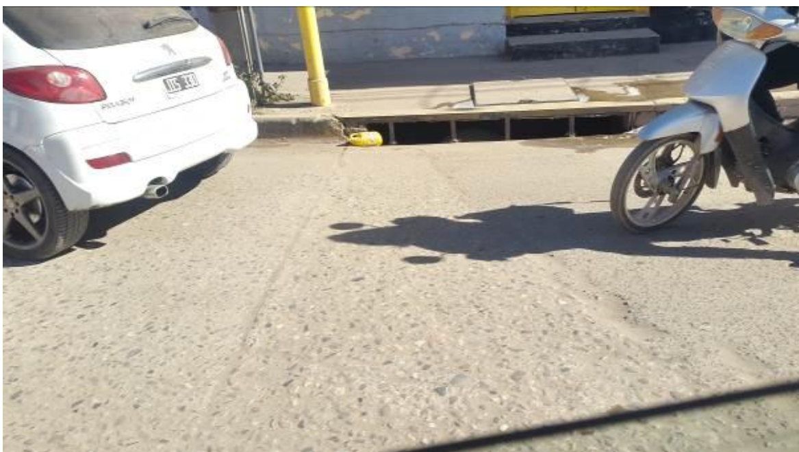
Figura 31: Sumidero Oeste calle Lavalle y Bv. Dalle Mura.
