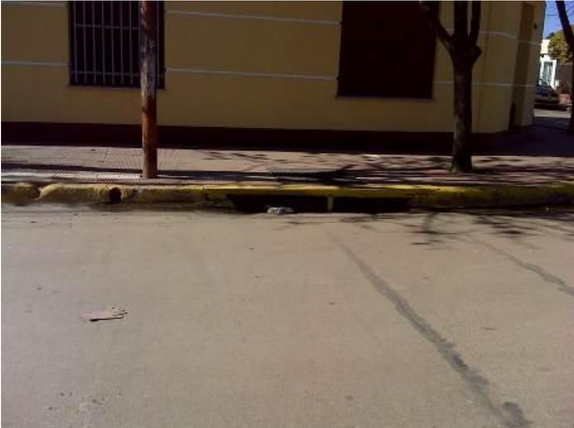
Figura 22: Sumidero calle Mitre esquina Gral. Paz.
