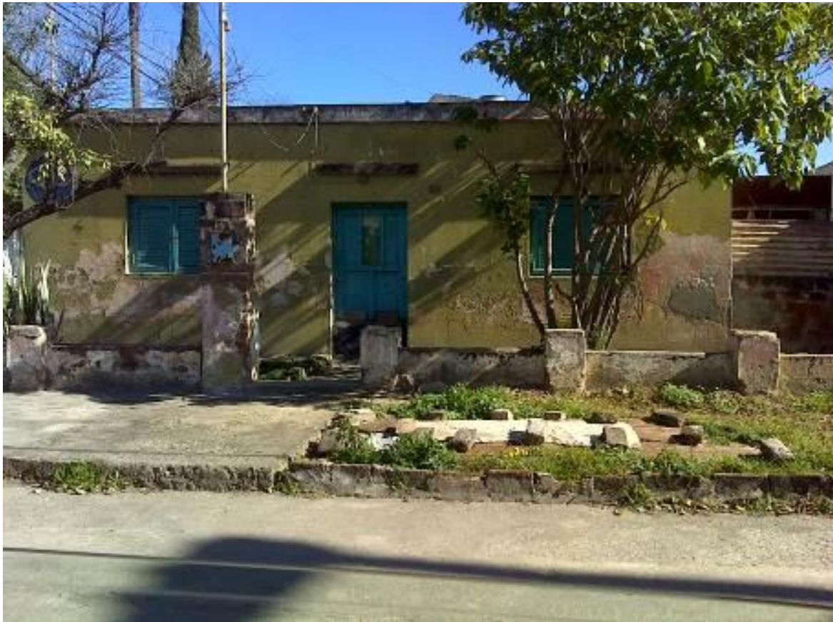
Figura 20: Vivienda con umbral tapiado calle Mitre esquina Vicenta Ríos de Vocos.
