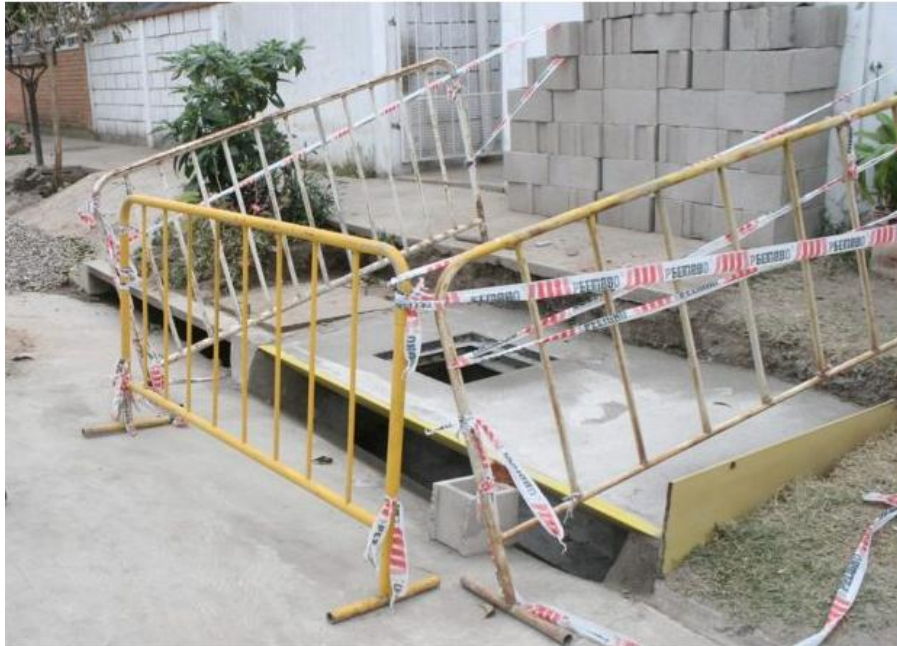
Figura 70: Nueva boca de tormenta.
