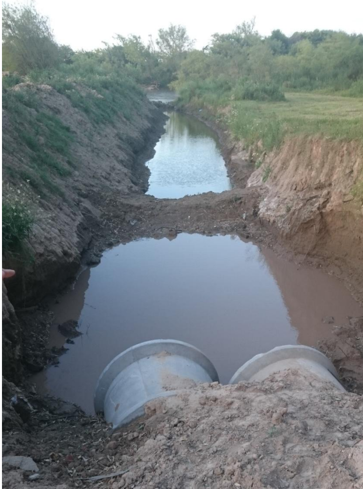
Figura 65: Obra sobre tramo final de calle Rafael Nuñez.
