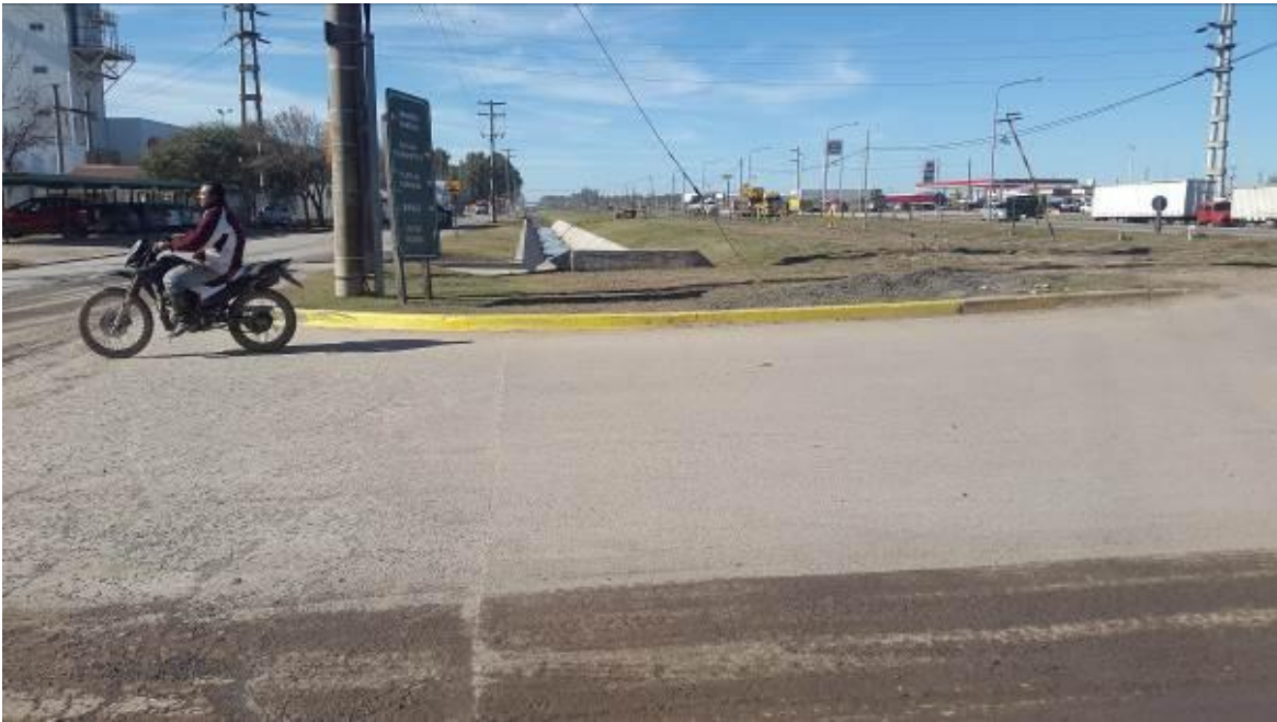
Figura 33: Desagüe a cielo abierto Bernardi esq. Ruta 19.
