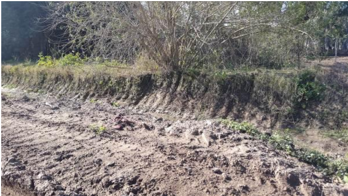
Figura 35: Sección del canal Bernardi entre Av. Marcial Vaudagna y descarga al río.
