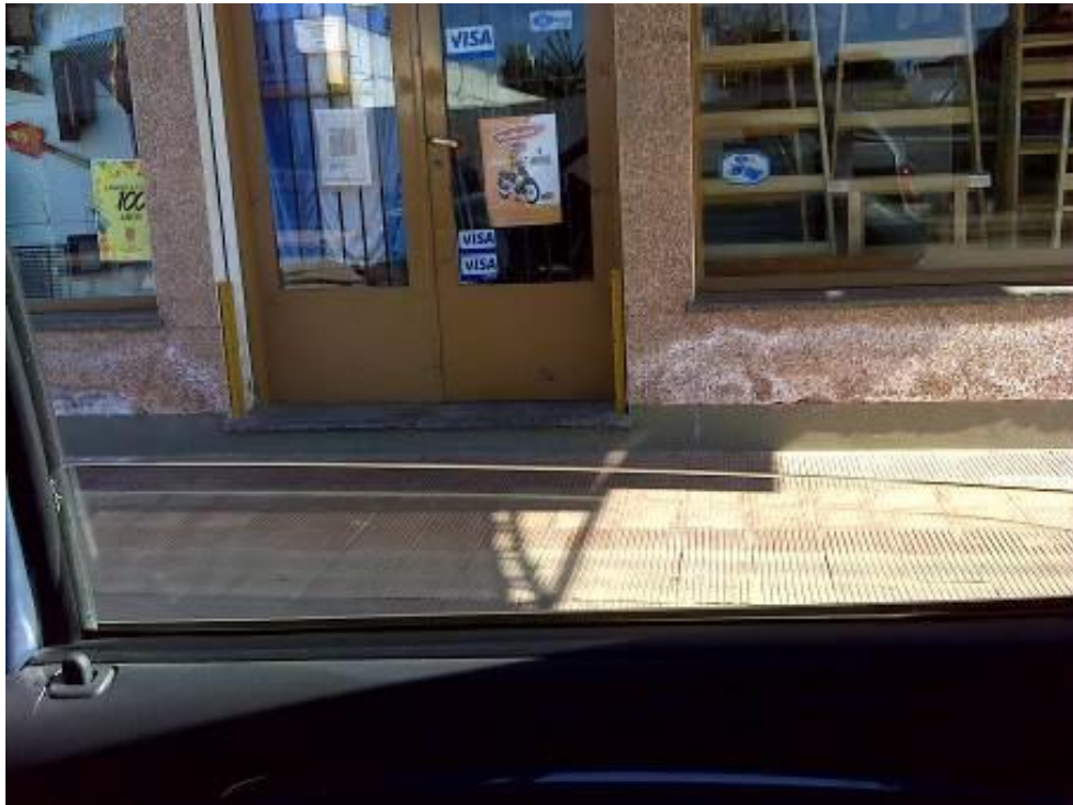
Figura 23: Guías de compuerta en comercio de calle Mitre.
