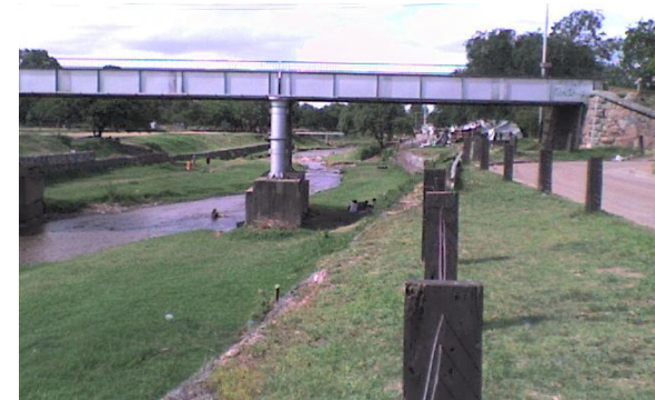
Puente vehicular y río Jesús María próximos al anfiteatro Foto propia. 2006.
