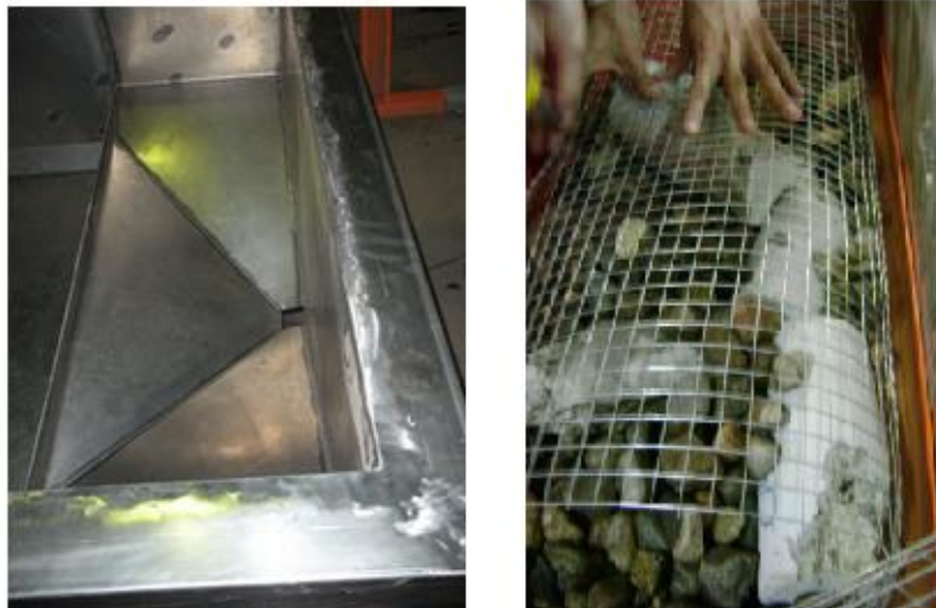
Figura 8: Tolva de ingreso y egreso a la izquierda, dissipador de energía a la derecha.
