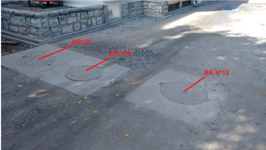
Figura 5.14 - Boca de registro de válvula de retención, Boca de registro N°5 línea del Laboratorio, Boca de registro N°13 línea del Comedor Universitario.
