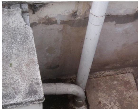
Figura 5.29 - Incorporación del caño pluvial en la boca de registro
