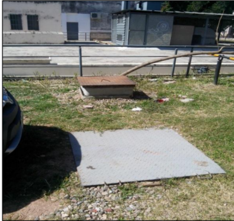
Figura 5.21 - Vista de la tapa de la boca de registro N°2
