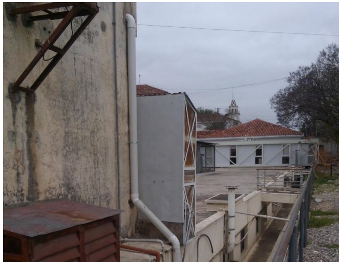
Figura 5.28 - Descenso de caño pluvial sobre red cloacal
