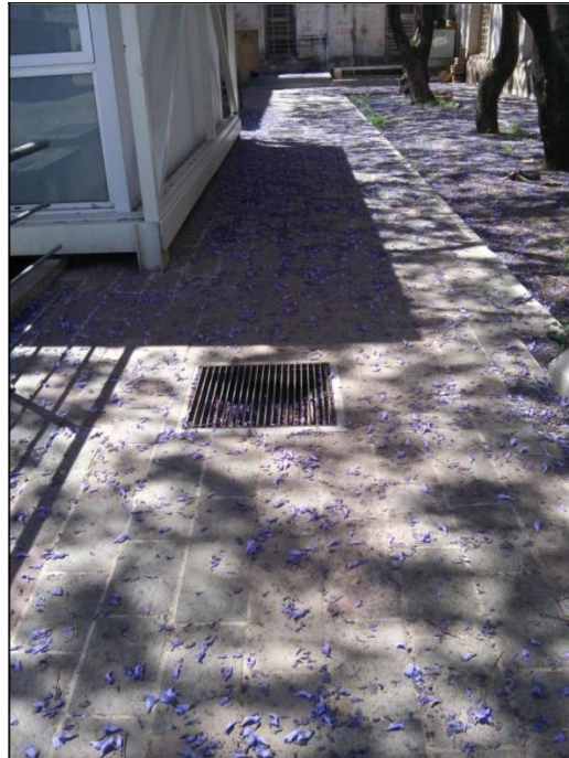
Figura 6.2 - Sumideros destinados al desagüe pluvial
