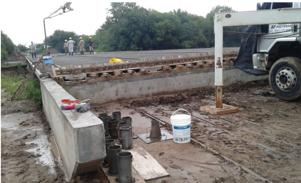
Ilustración 13: Colado de H° sobre prelosas.
