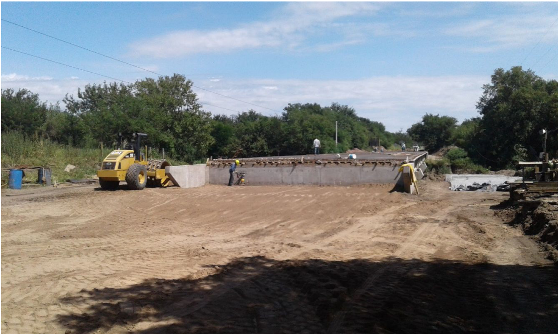
Ilustración 9: Terraplén preparado para relevamiento topográfico.
