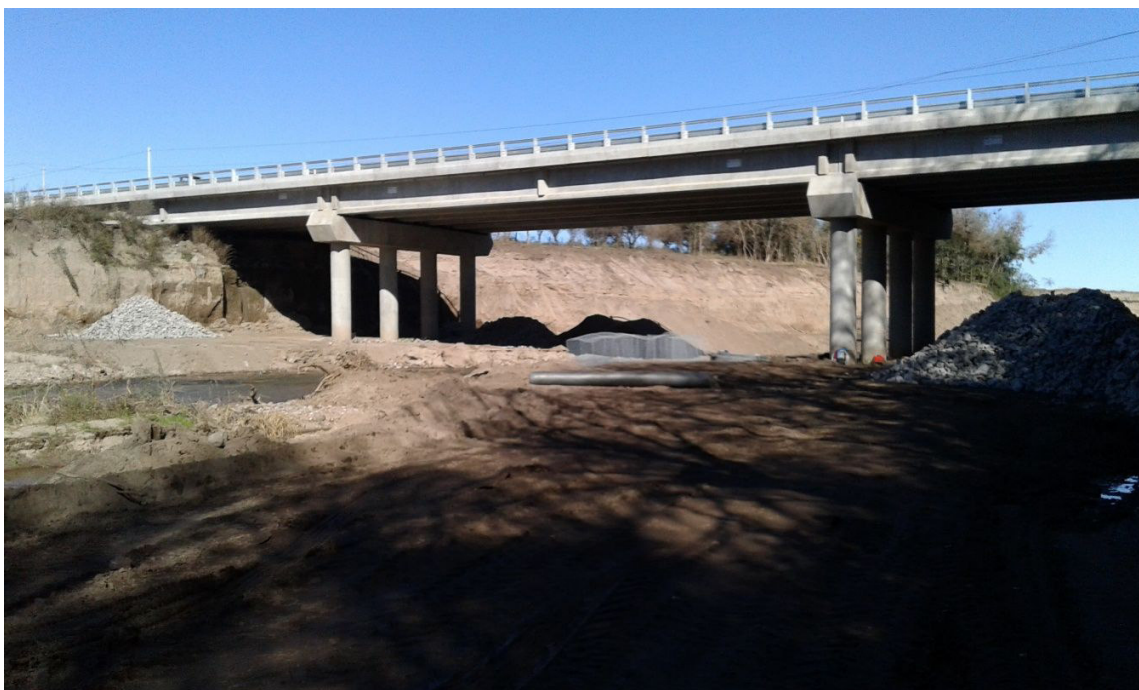
Ilustración 7: Puente Nuevo sobre Río Ascochinga
