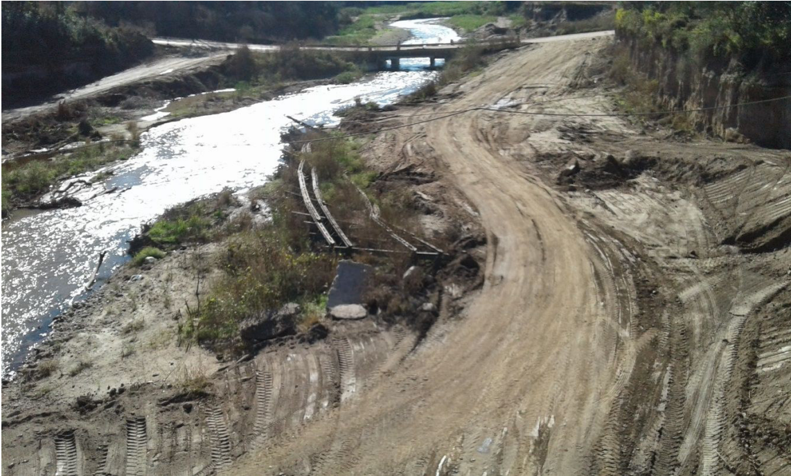
Ilustración 6: Puente tipo Bailey arrasado por las crecidas
