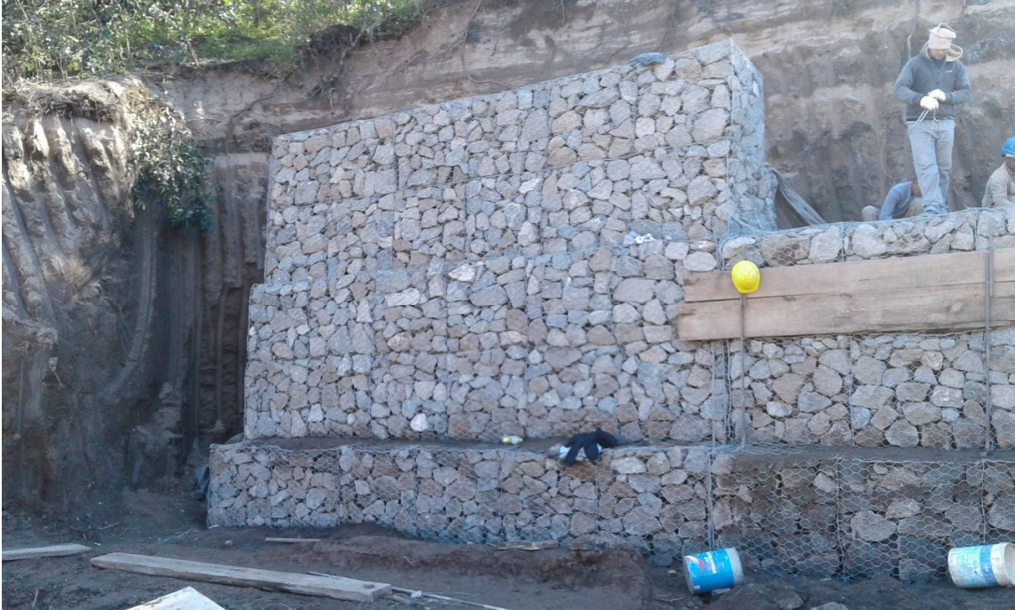
Ilustración 8: Ejecución de gaviones.
