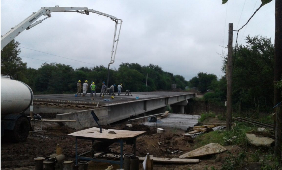
Ilustración 14: Colado de H°.
