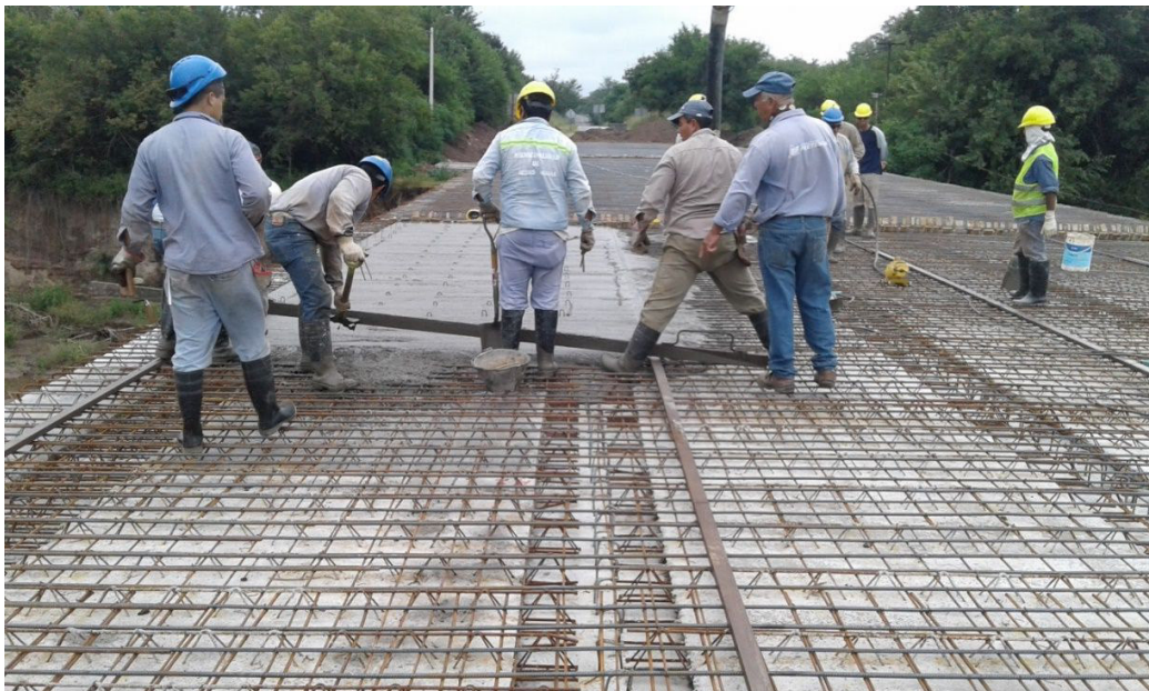
Ilustración 15: Cuadrilla trabajando en colado de H°
