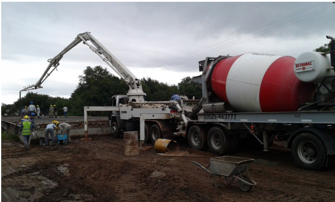
Ilustración 11: Bombeo de H° Elaborado mediante pluma
