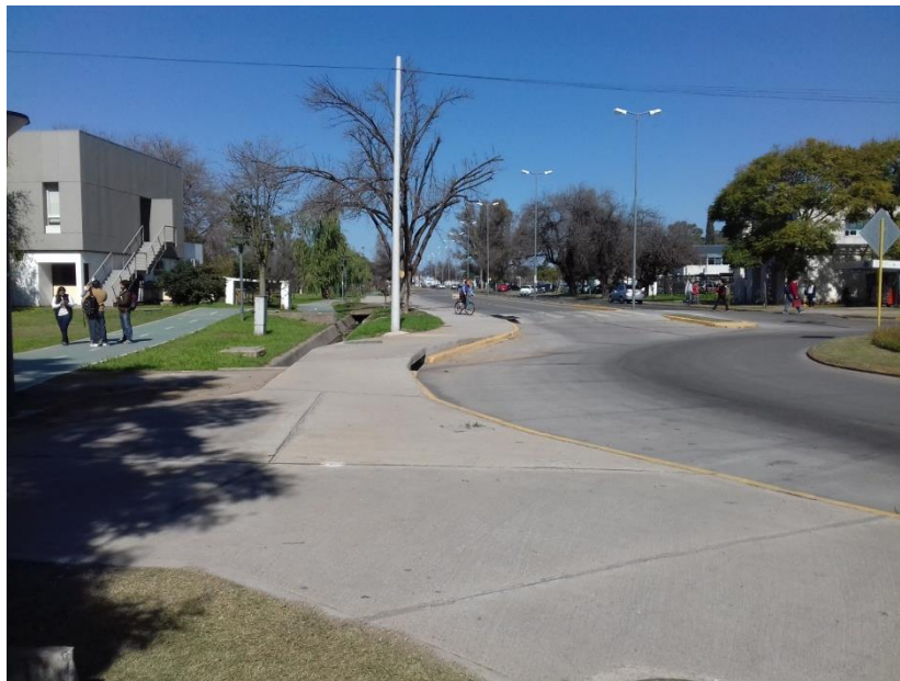
Fig N°20-b: Cruce entre la Av. Cd. De Valparaíso y la Av. Haya de la Torre. Fuente: Kornfeld, Natalia.
