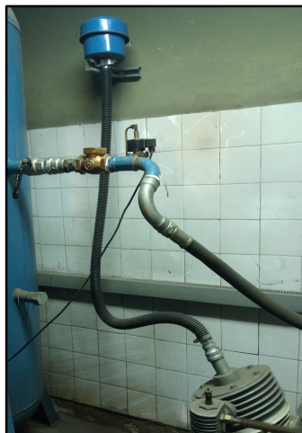
ILUSTRACIÓN 47. CONEXIÓN DEL FILTRO DE AIRE AL COMPRESOR
