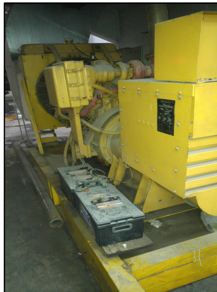
ILUSTRACIÓN 57. GRUPO ELECTRÓGENO
