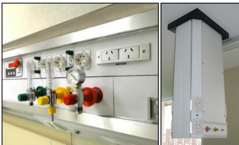
ILUSTRACIÓN 26. PANEL DE CABECERA Y COLUMNA DE TECHO
