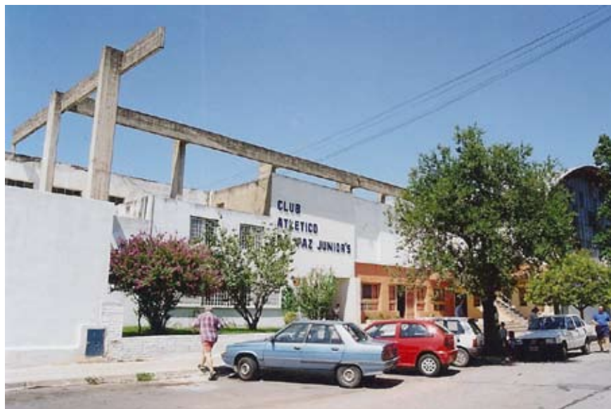
Vista escorzada del Club General Paz Juniors, en la que se dejan ver obras inconclusas de antigua data, así como una sucesión de fachadas de diversas épocas y de expresión incoherente.
