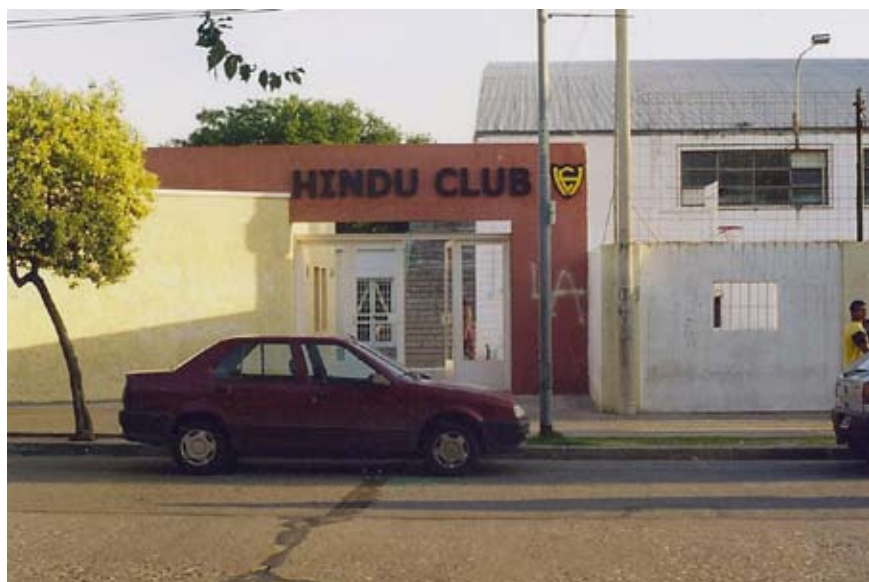
Fachada principal del Club Hindú, sobre Sarmiento. Este club también tiene presencia sobre las calles Jacinto Ríos y Pringles -donde comparte la cuadra con el Centro Cultural General Paz-, pero todo su perímetro, salvo en el acceso, se corporeiza con un paredón ciego.
