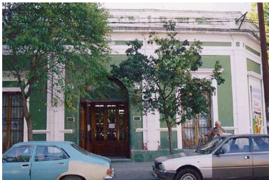
La Biblioteca Vélez Sarsfield, levantada por iniciativa popular, en la esquina de Félix Frías y Lima. La fotografía muestra su ingreso, en la fachada sur, que enfrenta a la plaza Alberdi.
