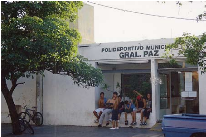
Entrada principal del Polideportivo, carente de la escala y de la jerarquía necesaria, no sólo por su carácter institucional, sino para proveer de una salida rápida ante una emergencia.
