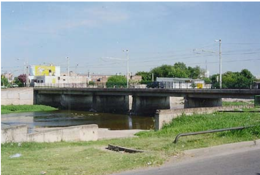
El puente Maldonado visto desde la avenida costanera en barrio San Vicente.
