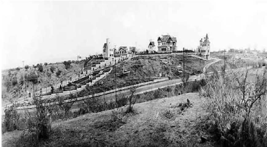
Panorama de los terrenos de la futura Ciudad Universitaria, antes de los inicios de las obras.
