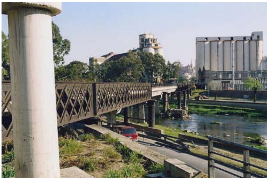
Otra vista, escorzada, de los dos puentes ferroviarios.
