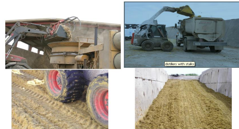
Fig. 5. Confección del Silo bunker
