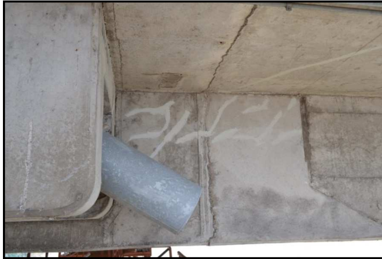
Figura 6.10. Fisuras selladas en tablero del Puente Principal
