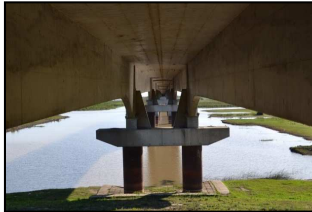
Figura 6.15. Vista inferior del tablero-Puente Carbón Grande 1
