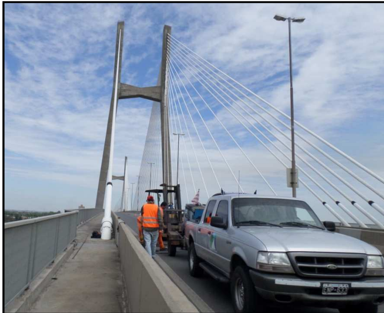
Figura 4.1. Puente Principal-Personal de mantenimiento realizando arreglos en junta de dilatación
