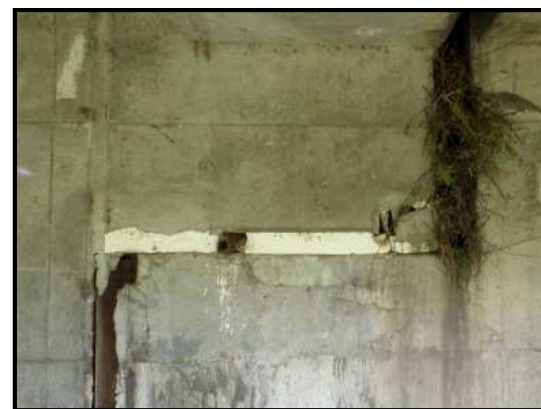
Figura 6.12. Presencia de nidos en junta Gerber N° 16-Aguas abajo-Viaducto de Acceso Este
