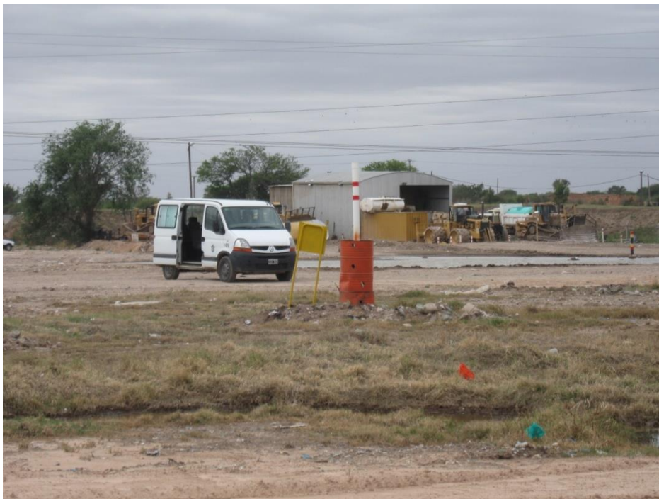
Figura N° 3.4: Chimenea de venteo de gases
