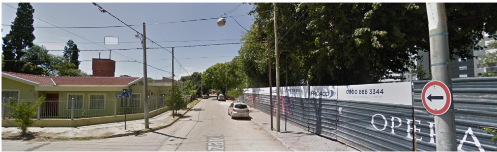
Fig. 37. Google Street View. 2022. [ Contraste de altura y fragmentación urbana en el entorno de Opera Luxury Condominio en el área intermedia ]
