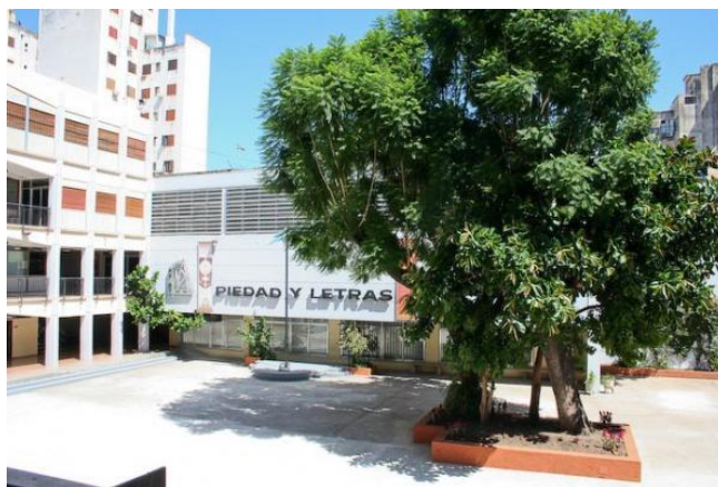
Figura N° 1: patio interno del colegio.
