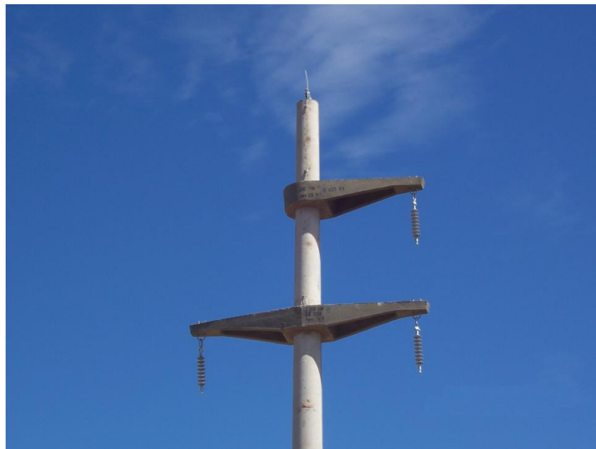
FIGURA 6 MÉNSULA Y CRUCETA MONTADAS
