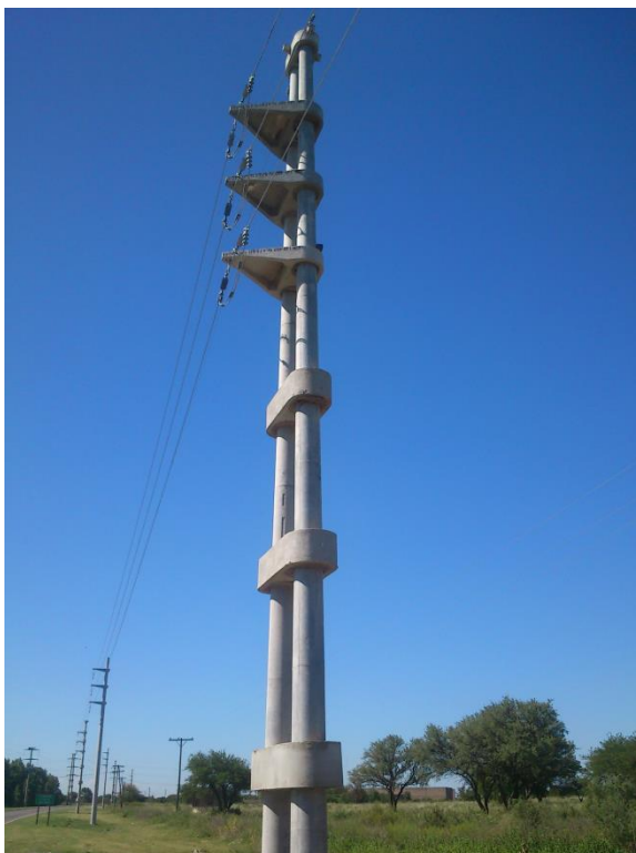
FIGURA 4 ESTRUCTURA DOBLE CON 3 MÉNSULAS Y 3 VÍCULOS
