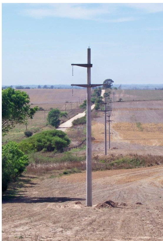
FIGURA 5 ESTRUCTURA SIMPLE CON 1 MÉSNULA Y 1 CRUCETA
