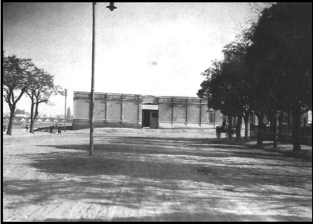
Edificación que desaparecerá con la avenida Costanera
