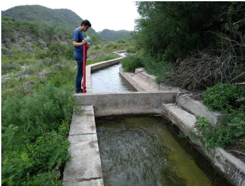
Imagen 10: Canal Maestro Soto en su tramo revestido antiguamente
