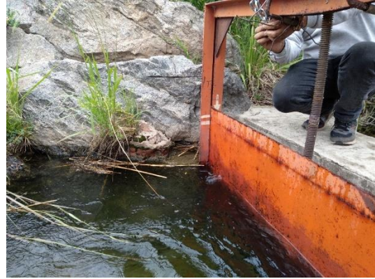
Imagen 9: Compuerta de ingreso Canal Maestro Soto sobre azud nivelador
