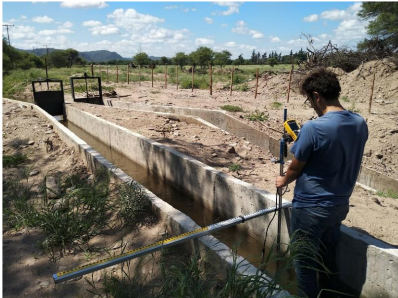
Imagen 16: Compuertas Canal Los Indios y Canal Las Tapias
