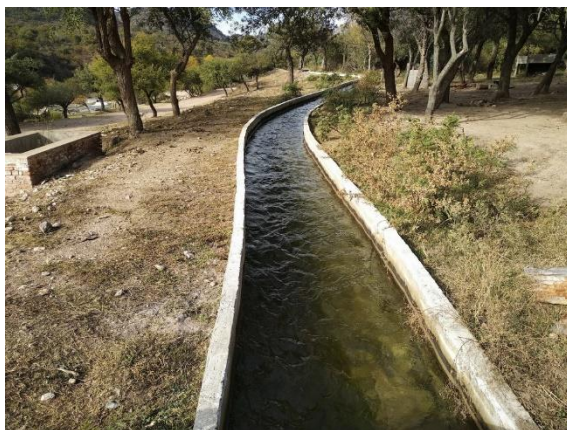
Imagen 12: Canal Maestro Soto tramo nuevo revestido
