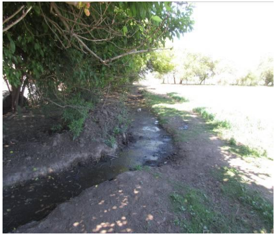
Figura 23: Canaleta a suelo desnudo próxima a gestación.
