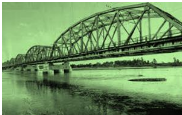
Figura 17 Foto Puente Carretero en Santiago del Estero. http://santiagoeducativo.com/puentecarretero/Recuperado el 05-01-2021.
