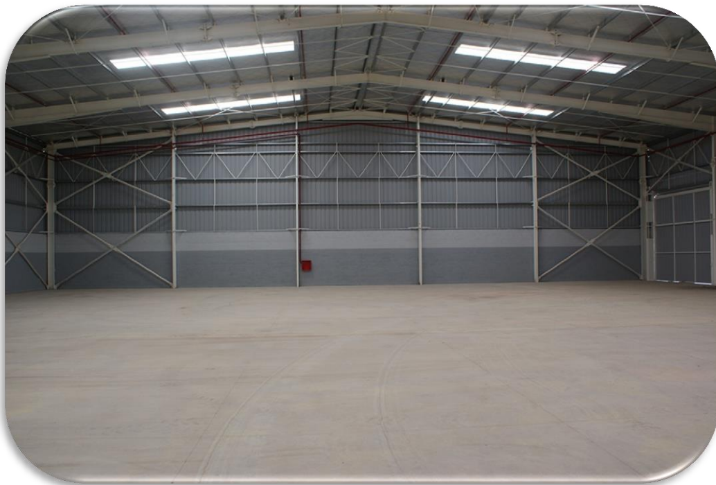
Figura 35 – Vista interior de la nave I
