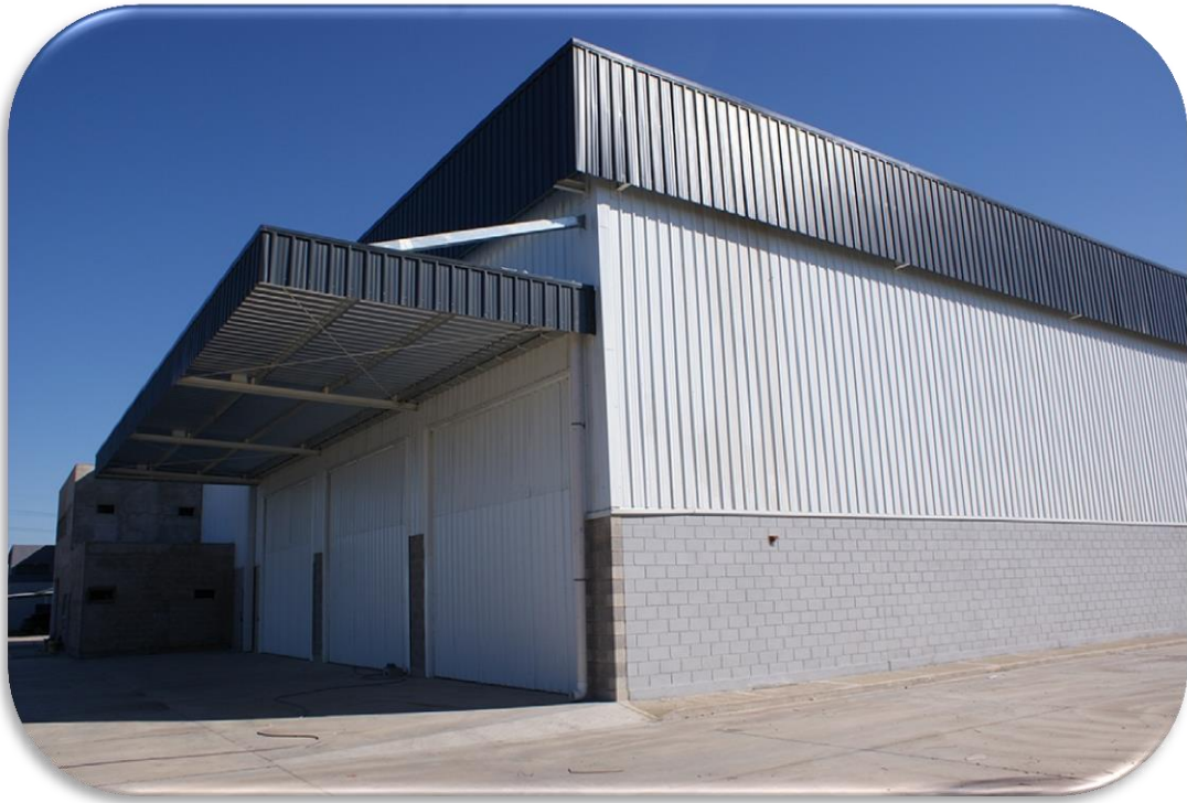
Figura 34 – Vista exterior de la nave II
