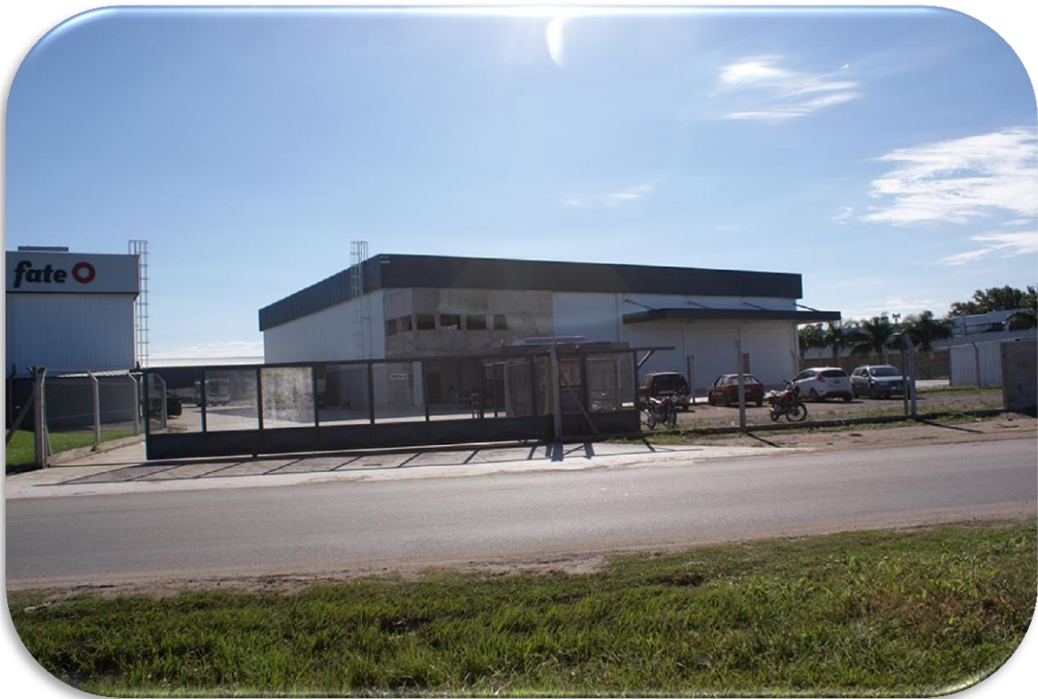
Figura 38 – Vista frontal del predio
